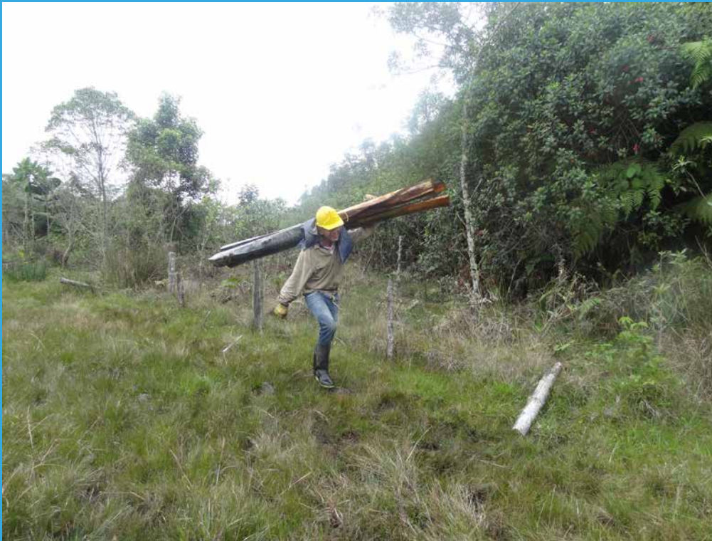
Foto. Cargue y descarga de postería.
