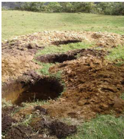
*Actividades de excavación de los hoyos
