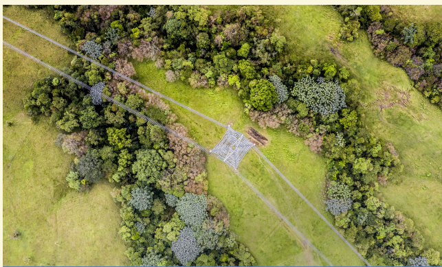
Filandia, Quindío – Activo en operación Armenia 230 kV
