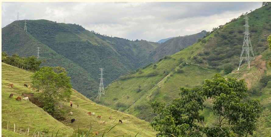
Torres proyecto Refuerzo Suroccidental 500 kV, Angelópolis -Antioquia
