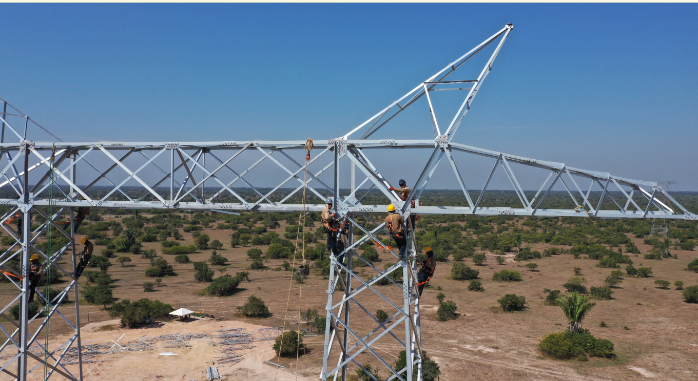
Construcción subestación La Loma. La Loma de Calenturas
