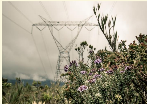
Activo en operación Grupo Energía Bogotá
