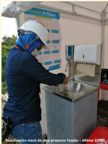
Reactivación inicio de obra proyecto Tesalia – Alférez 230KV
