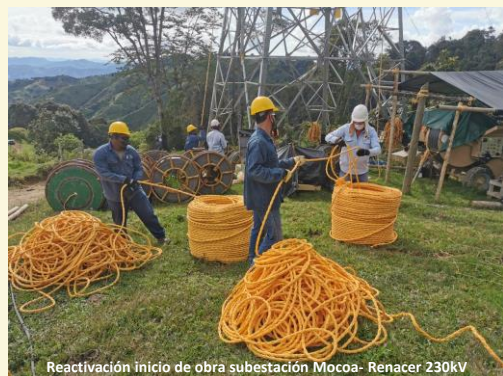
Reactivación inicio de obra subestación Mocoa- Renacer 230kV
