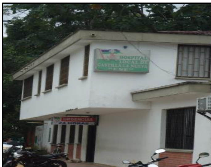
Fotografía 4.4-17 Hospital local del municipio de Castilla La Nueva E.S.E
