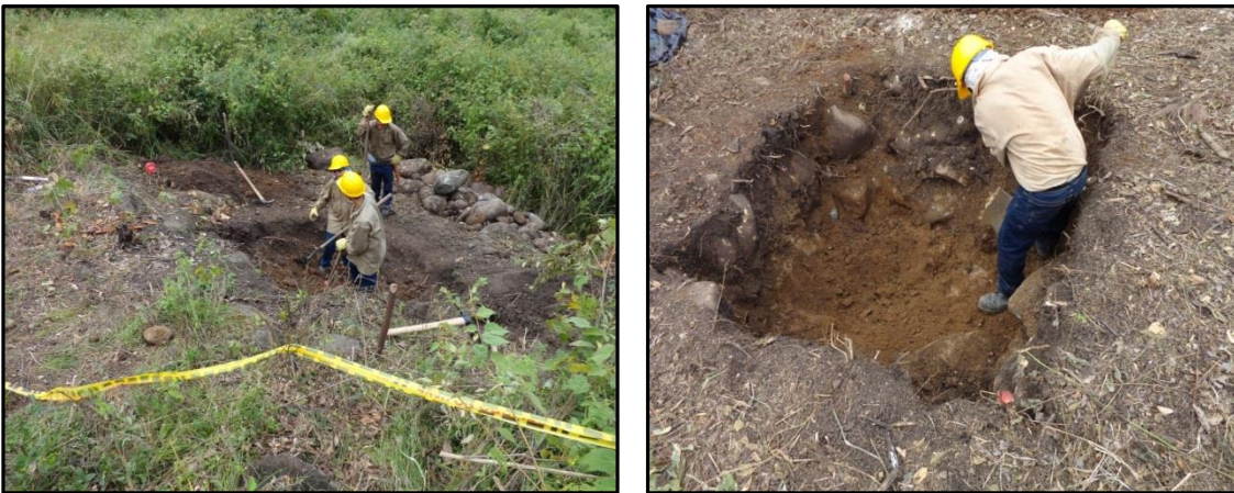
Fotografía 3-12 Excavación para cimentación de torres
