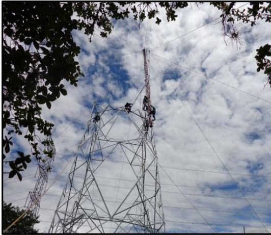
Fotografía 3-15 Armado de torres
