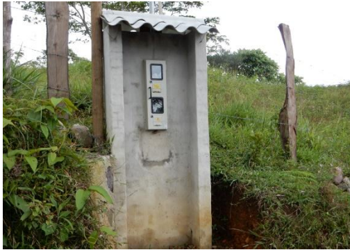
Fotografía 6-11 Servicios públicos (energía) en la zona rural (municipio Villavicencio)
