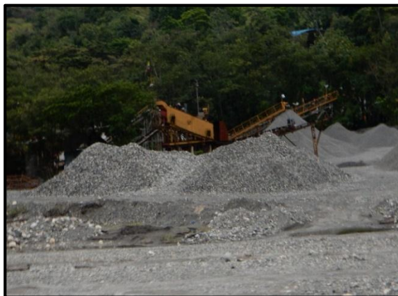
Fotografía 6-18 Extracción de material de arrastre Río Guayuriba
