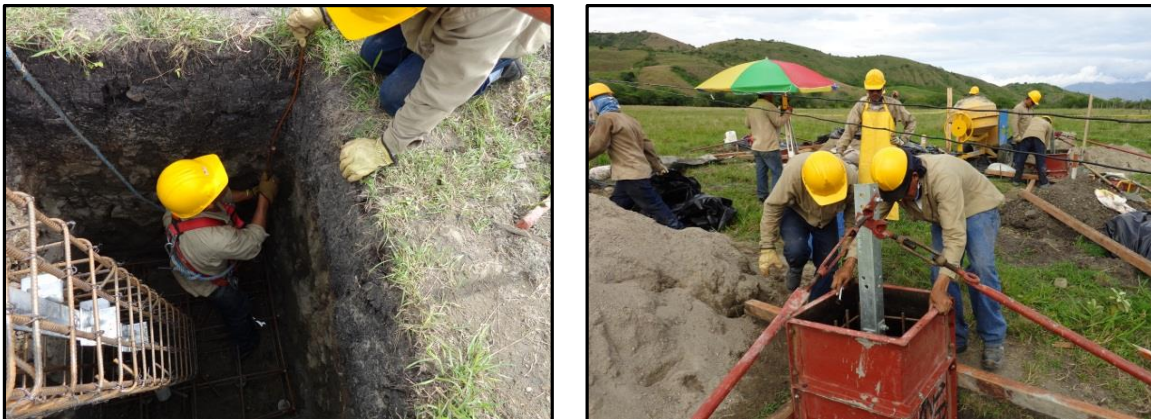
Fotografía 3-13 Cimentación de torres
