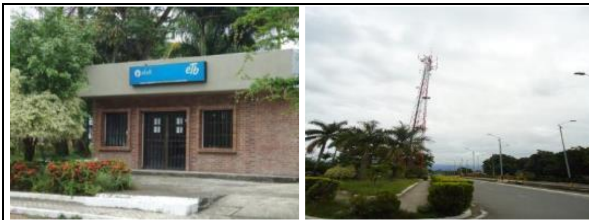
Fotografía 4.4-11 Sede de Empresa de Telecomunicaciones ETELL - Torre repetidora
