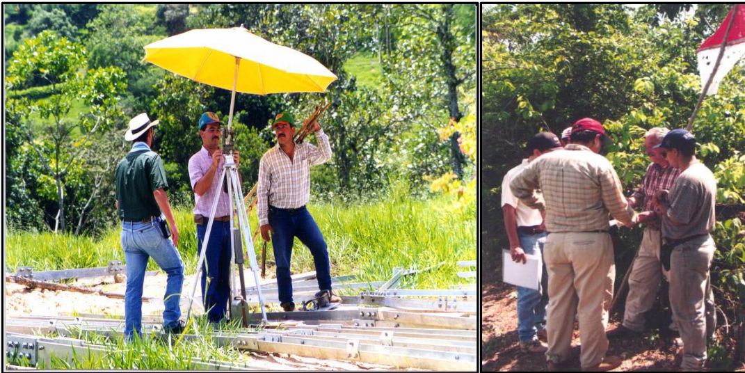
Fotografía 3-9 Replanteo de construcción
