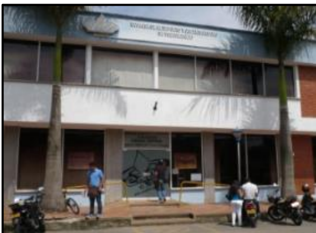
Fotografía 4.4-9 Empresa de Acueducto y Alcantarillado de Villavicencio
