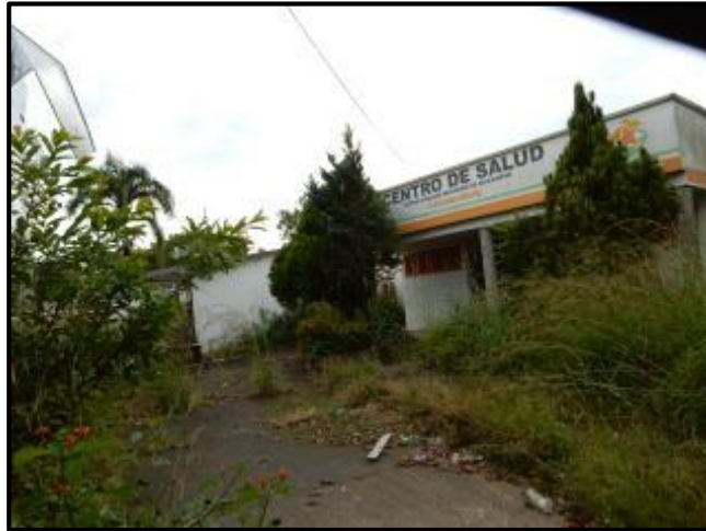
Fotografía 4.4-22 Centro de salud San Isidro de Chichimene Fuente: Antea Group, 2015
