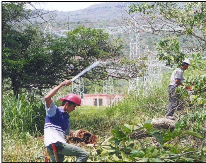
Fotografía 3-21 Control de vegetación
