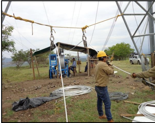
Fotografía 3-17 Tendido de los conductores
