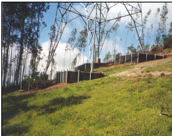
Fotografía 3-20 Control de estabilidad de sitios de torre
