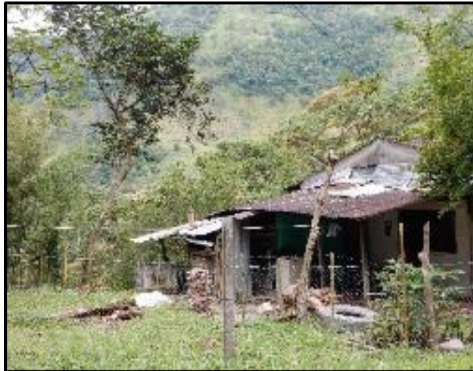
Fotografía 4.2-48 Chimenea de estufa de leña Fuente: Antea Group, 2015
