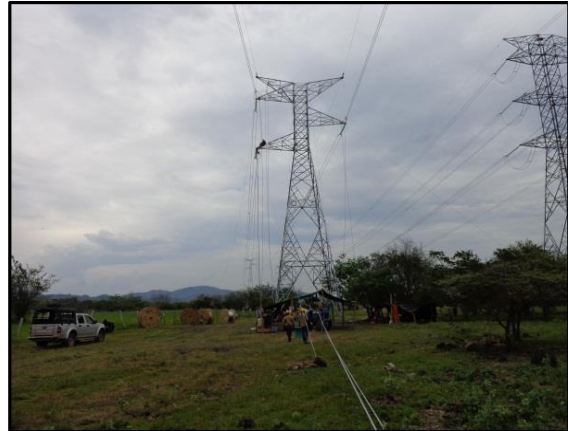
Fotografía 3-17 Tendido de los conductores
