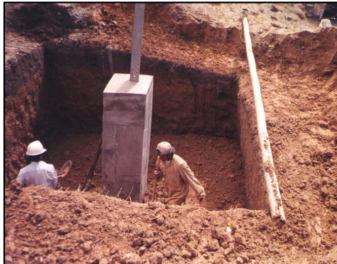
Fotografía 3-14 Relleno y compactación de materiales en torres
