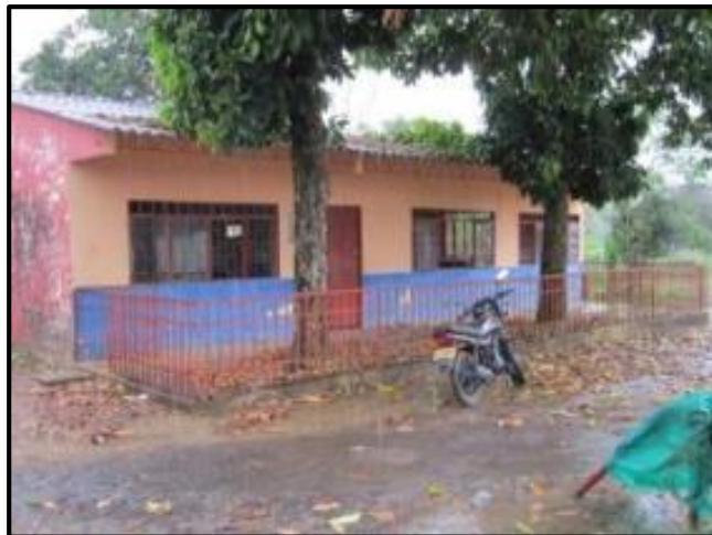
Fotografía 4.4-23 Vivienda tipo de la Inspección San Isidro de Chichimene Fuente: S.G.I. Ltda Consultoría e Ingeniería
