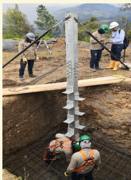
Municipio de Garagoa, instalación de torre 170
