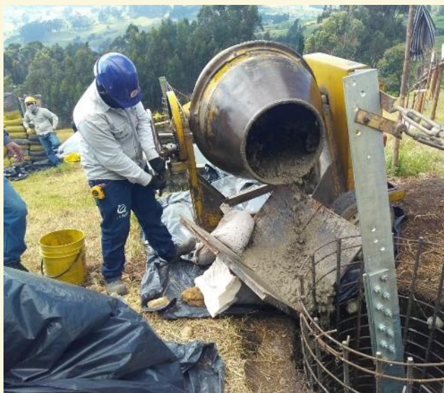
Actividades de vaciado de concreto en el sitio de torre NB52, ubicado en la vereda Barro blanco, en Zipaquirá.
