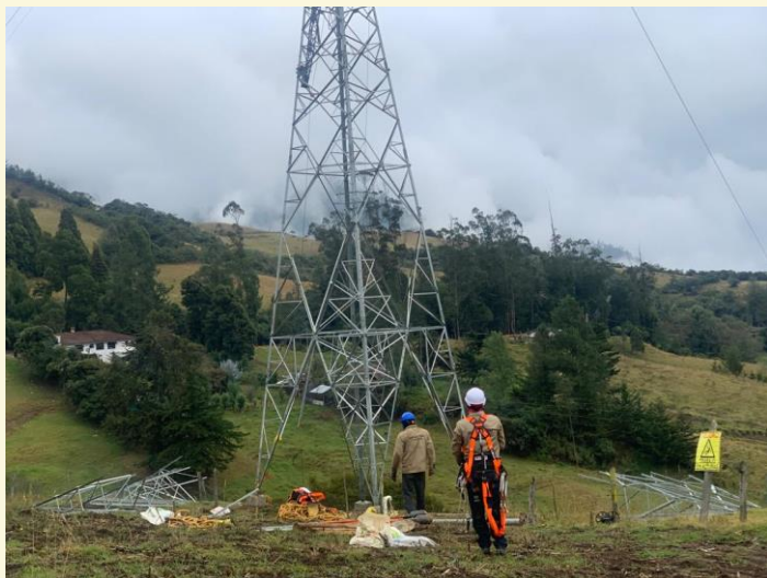
Montaje torre 123 vereda Boquerón de Chocontá
