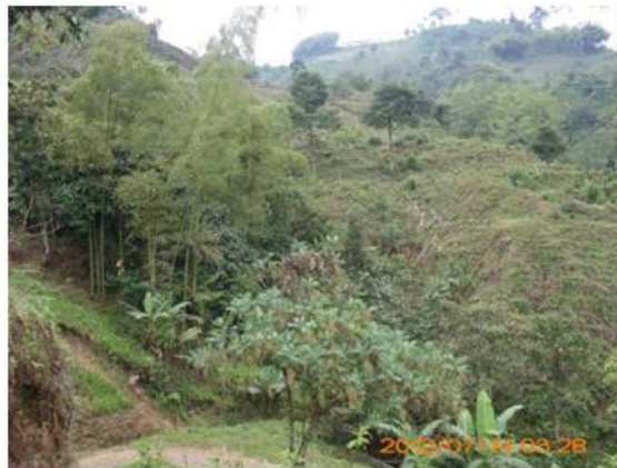
Foto 3.5 Signos de inestabilidad en zonas cerca de la autopista del café
