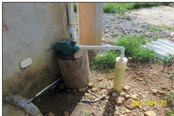
Fotografía 3.2-110 Pozo P13, Municipio de Acacias – vereda Santa Teresita
