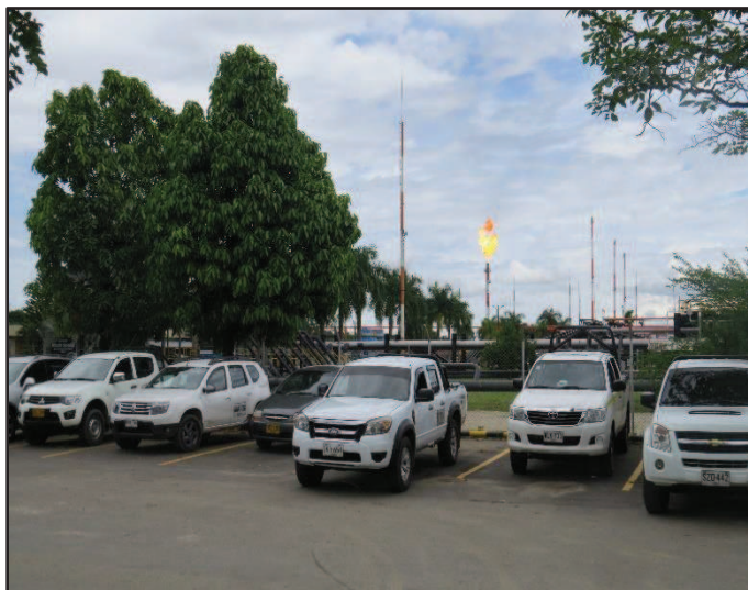
Fotografía 3.2-125 Actividad petrolera en la vereda San Isidro de Chichimene Fuente: CONSORCIO INGEDISA DESSAU ANTEA SAN FERNANDO, 2017
