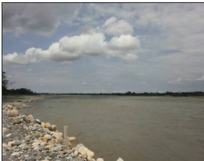
Fotografía 3.2-71 Panorámica río Guayuriba – La Concepción. E: 1038141,50 N: 938025,71 Fuente: CONSORCIO INGEDISA DESSAU ANTEA SAN FERNANDO, 2016.
