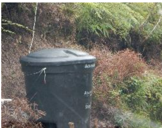
Tanque de Acueducto vereda Samaria
