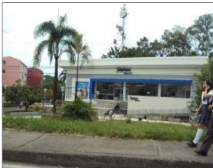
Fotografía 3.4-12 Sede telefónica Movistar municipio de Villavicencio Fuente: S.G.I. Ltda. Consultoría e Ingeniería.
