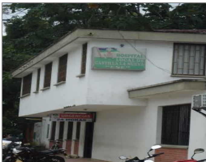
Fotografía 3.4-17 Hospital local del municipio de Castilla La Nueva E.S.E
