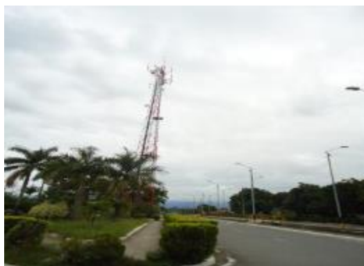
Sede de Empresa de Telecomunicaciones ETELL - Torre repetidora Fuente: S.G.I. Ltda. Consultoría e Ingeniería
