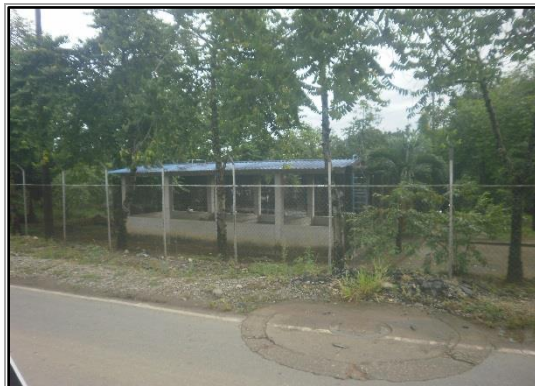
Fotografía 5-20 Planta de tratamiento de agua residual centro poblado San Isidro de Chichimene E: 1043720,7054 N: 924383,6077
