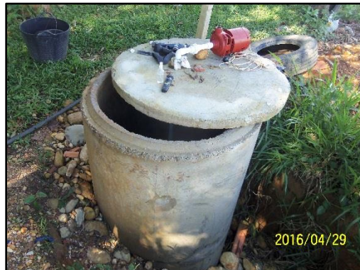
Fotografía 5-14 Aljibes instalados en la zona de planicie municipio de Acacias.
