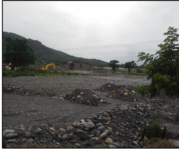
Fotografía 5-30 Extracción de materiales de río en la vereda La Concepción, Coordenadas origen MAGNA Colombia Bogotá, Este: 1034609,1735 Norte: 939564,798283 tomada en dirección sur este. Fuente: CONSORCIO INGEDISA DESSAU ANTEA SAN FERNANDO, 2017
