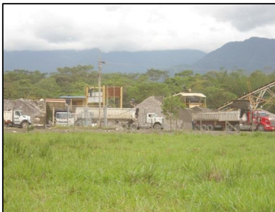
Fotografía 5-7 Sector donde se realiza la clasificación y almacenamiento de los materiales de arrastre; Coordenadas Magna Sirgas Origen Bogotá E= 1'038.235,00 N= 943.803,00.
