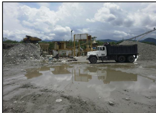
Fotografía 5-19 Actividad de extracción de material. Empresa Gravicol E: 1038418,685 N: 938016,53 Fuente: CONSORCIO INGEDISA DESSAU ANTEA SAN FERNANDO, 2017
