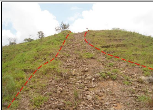
Fotografía 5-8 Derecho de vía perteneciente a una línea de flujo de hidrocarburos en la zona de montaña (demarcado por las líneas a trazos).; Coordenadas Magna Sirgas Origen Bogotá E= 1'041.187 N= 949.387.
