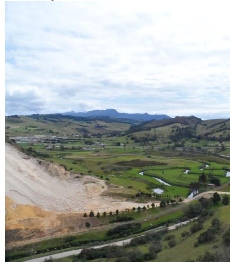
Fotografía 3-2 Red ferroviaria ubicada en el municipio de Choconta, Vereda Tilata
