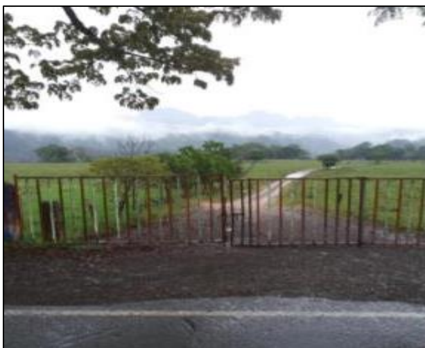
Fotografía 3-1 Acceso Lote subestación Chivor II – San Luis Fuente: EEB, 2016
