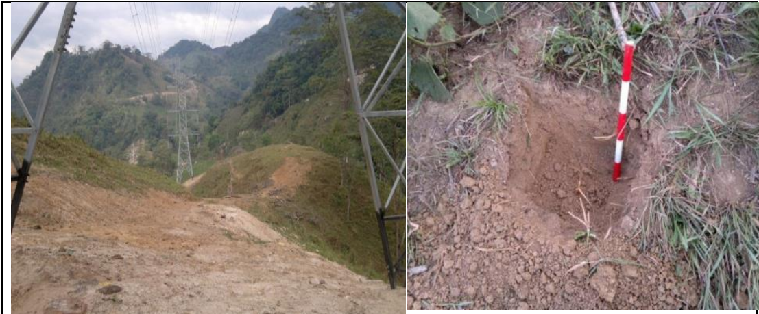
Fotografía 3-1 Localización torre T1A Coordenadas: X: 1099635 - Y: 1027928 Fuente: Consorcio Ambiental Chivor, 2014
