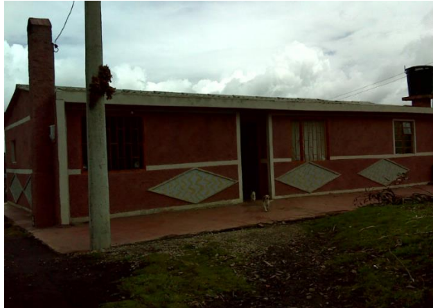
Fotografía 3-46 Tanque de almacenamiento predio vereda Barroblanco
