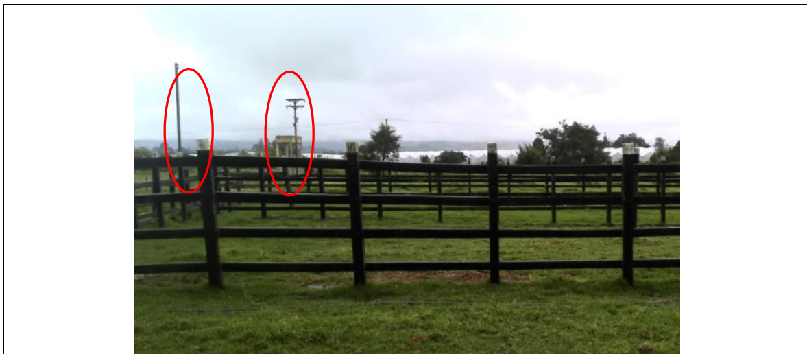
Fotografía 3-41 Postes de energía eléctrica predio vereda La Puerta
