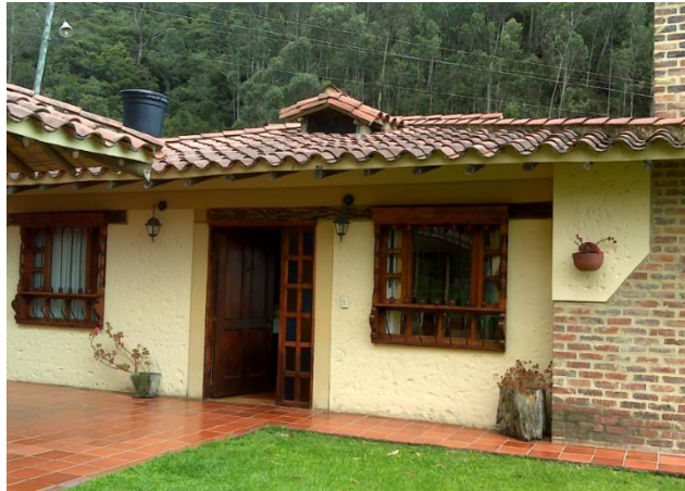
Fotografía 3-49 Tanque de almacenamiento predio vereda Santuario de la Cuesta
