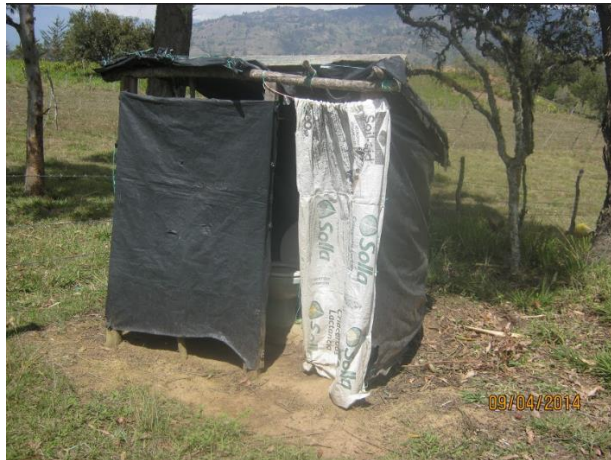
Fotografía 3-12 Inodoro conectado a pozo séptico vereda Caracol
