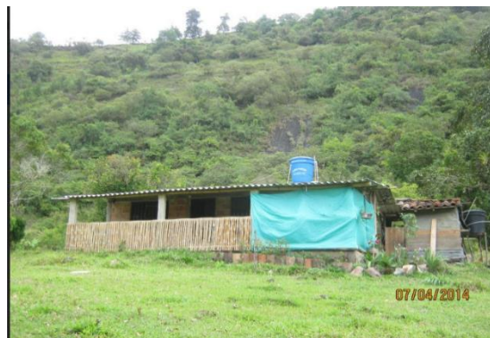
Fotografía 3-7 Tanques de almacenamiento predio vereda Dátil
