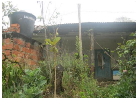
Fotografía 3-21 Tanque de almacenamiento predio vereda Medio Quebradas
