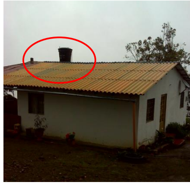
Fotografía 3-24 Tanque de almacenamiento predio vereda Resguardo Bajo
