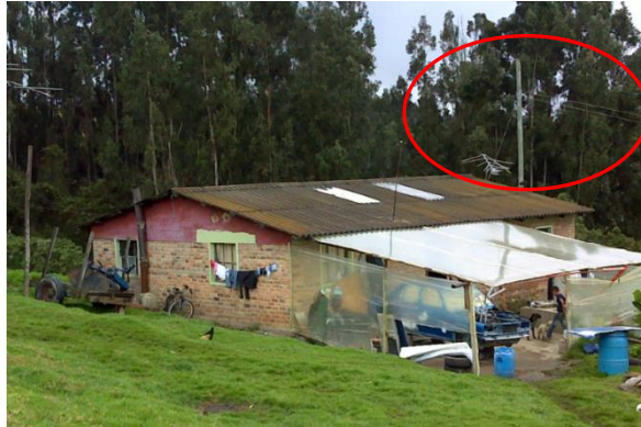
Fotografía 3-47 Poste y tendido eléctrico predio vereda Barroblanco
