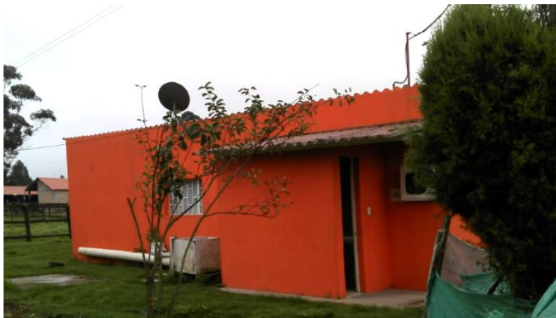
Fotografía 3-45 Inodoro conectado a pozo séptico predio vereda Rodamontal
