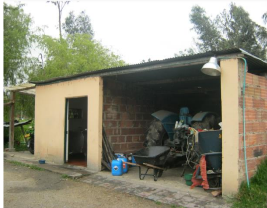
Fotografía 3-37 Lámpara eléctrica de predio vereda Boitá
