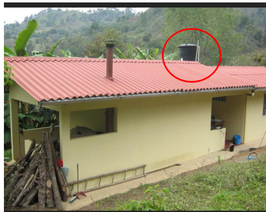
Fotografía 3-11 Tanque de almacenamiento predio vereda Arada Chiquita
