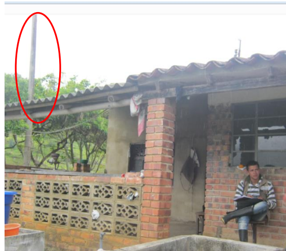
Fotografía 3-26 Postes de energía eléctrica predio vereda Resguardo Bajo
