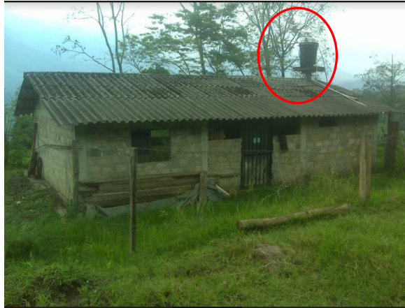
Fotografía 3-2 Tanque de almacenamiento predio vereda Planadas
