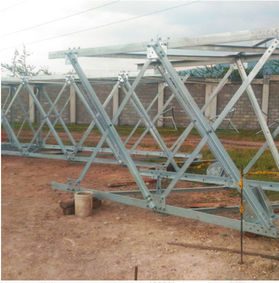
Prearmado de estructura
