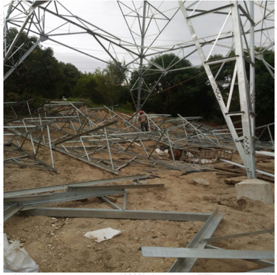
Prearmado de estructura
