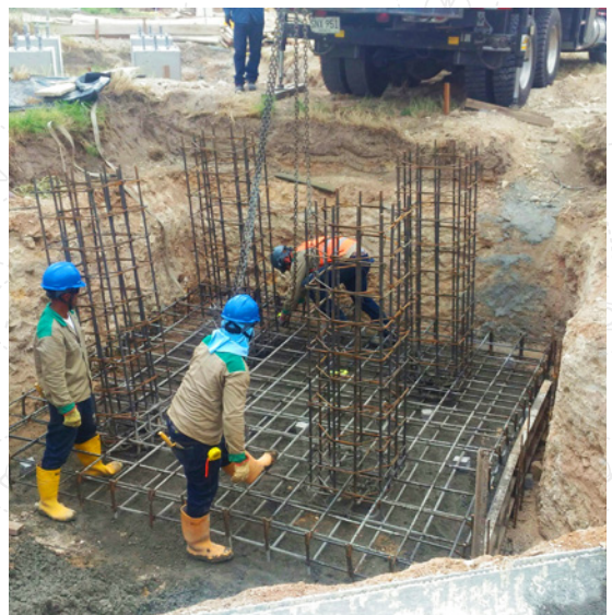
Armado de hierro de zapata
