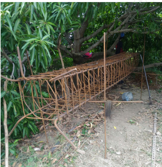
Armado de hierro de zapata
