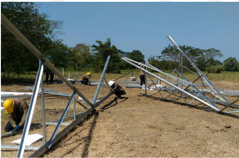
Prearmado de brazo de estructura
