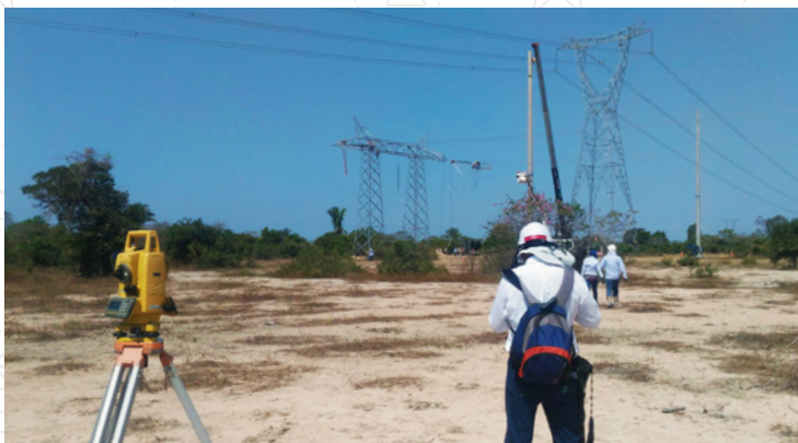
Verificación de elevación de conductor con topografía
