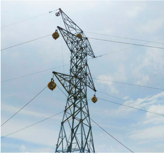
Torre con hilo piloto en las poleas de tendido
