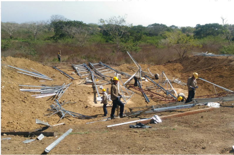
Movilización de estructura a sitio de montaje
