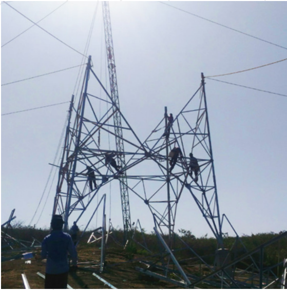
Montaje con pluma de izaje
