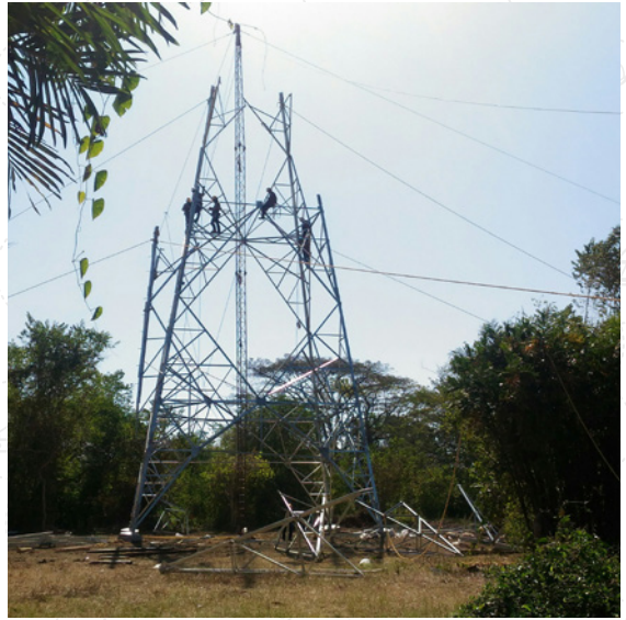
Montaje con pluma de izaje
