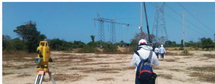
Verificación de elevación de conductor con topografía
