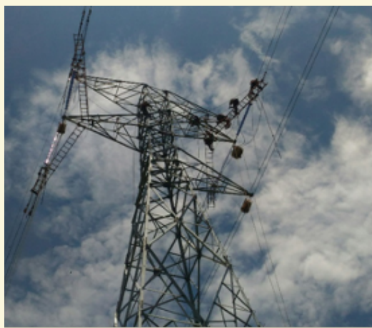
Torre con poleas de tendido instaladas
