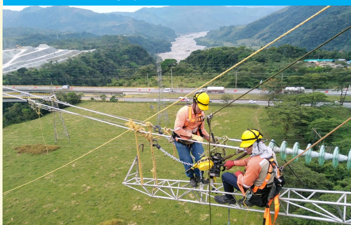
Tendido de cables proyecto La Reforma – San Fernando 230 kV
