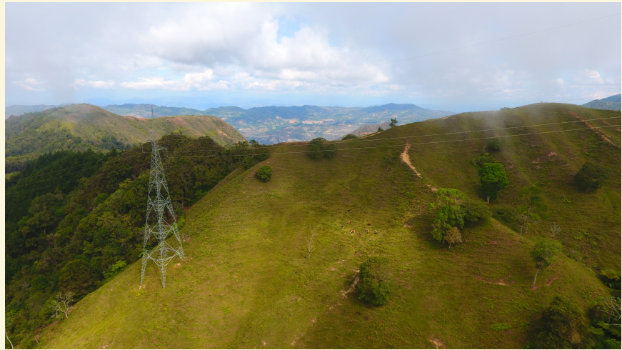
Línea de transmisión de energía eléctrica del Grupo Energía Bogotá
