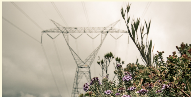
Activo en operación Grupo Energía Bogotá
