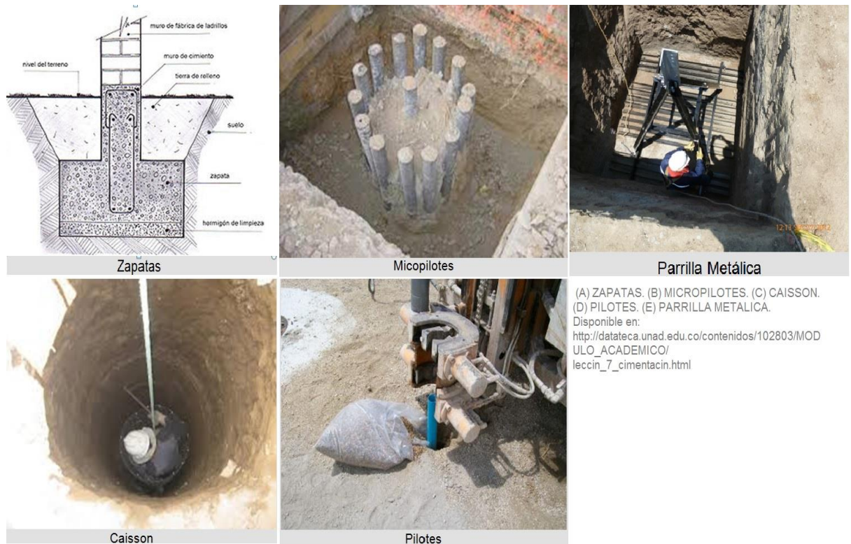
Figura 2.4 Tipos de cimentaciones
