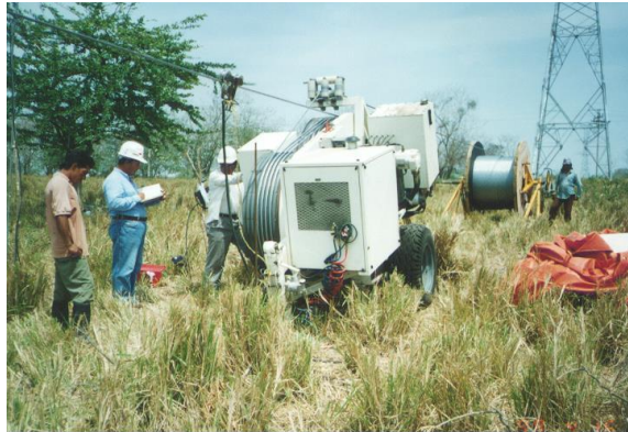
Figura 2.27 Freno de Tensión Controlada
