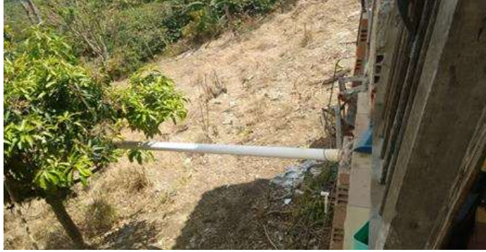
Foto 3.4.3.21 Disposición de residuos de inodoro sin conexión al alcantarillado, Vereda Salinas, Caldas.
