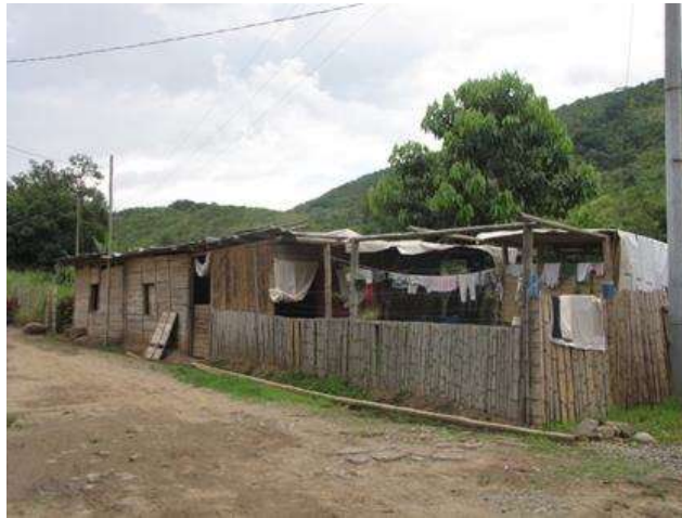
Foto 3.4.3.36 Vivienda con paredes de caña, vereda Beltrán, Marsella.
