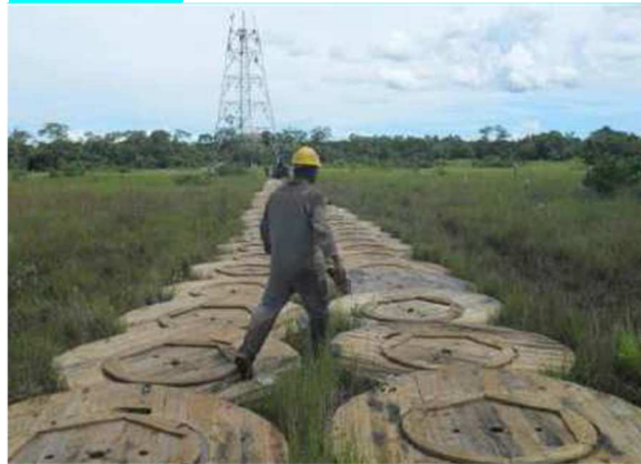
Fotografía 2-198 Colocación temporal de carretes de madera para acceso a sitios de torre en zonas susceptibles de inundación
