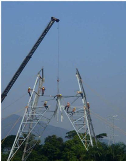
Fotografía 2-199 Montaje de torre con grúa
