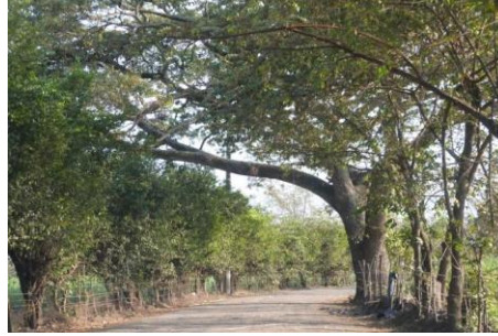
Fotografía 5-8 Vía sin pavimentar, corregimiento El Carmelo, Candelaria.
