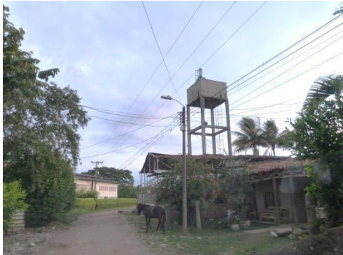
Fotografía 5-59 Tanque elevado de agua en vereda El Estero - Cali
