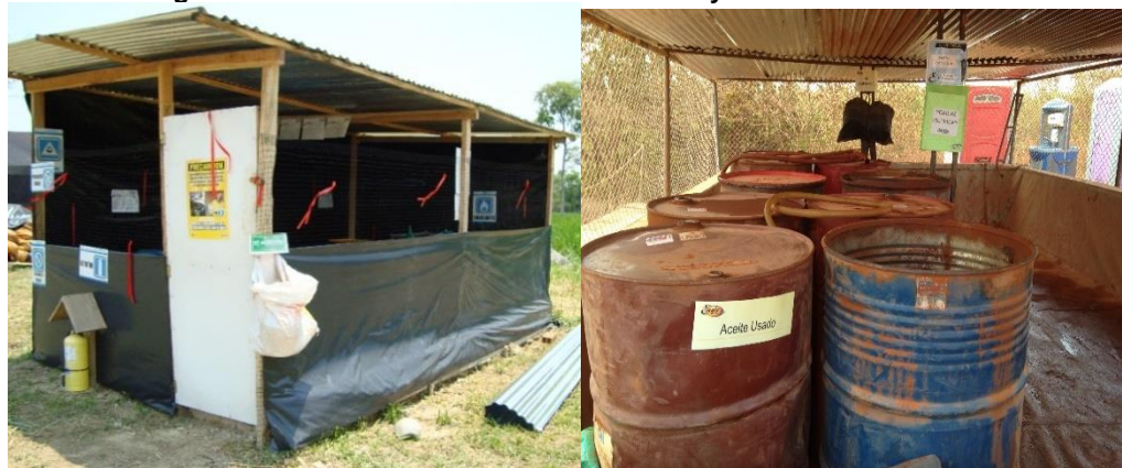
Fotografía 5 Almacenamiento de combustibles y aceites lubricantes
