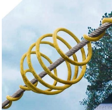
Fotografía 7 Modelo de desviador de vuelo instalado
