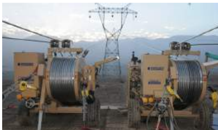
Fotografía 106. Plaza de tendido de freno
