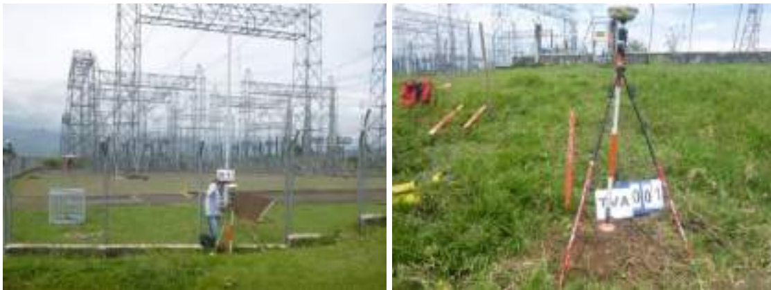
Fotografía 39. Sitio de torre TVA001
