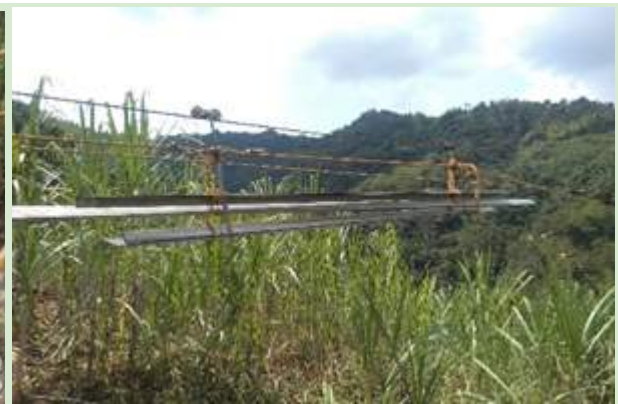
Cables y manilas: Elementos utilizados para llevar los materiales de un punto a otro.
