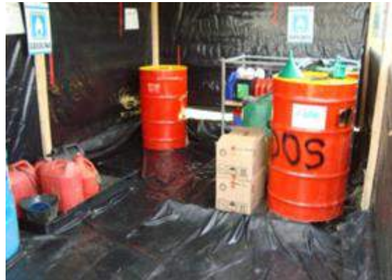
Fotografía 115. Ejemplo de recipientes y sitio de acopio de combustibles y similares para la fase de construcción
