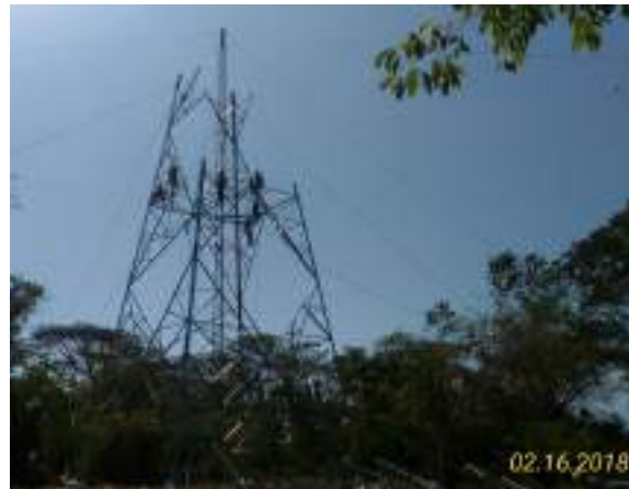
Fotografía 4. Montaje de torre con pluma
