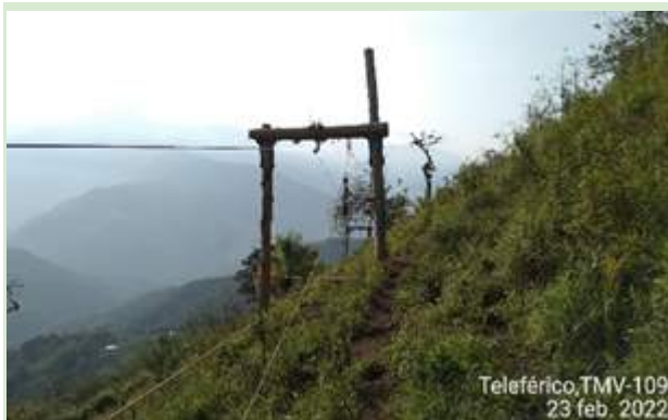
H: Elementos utilizados para darle altura a los cables
