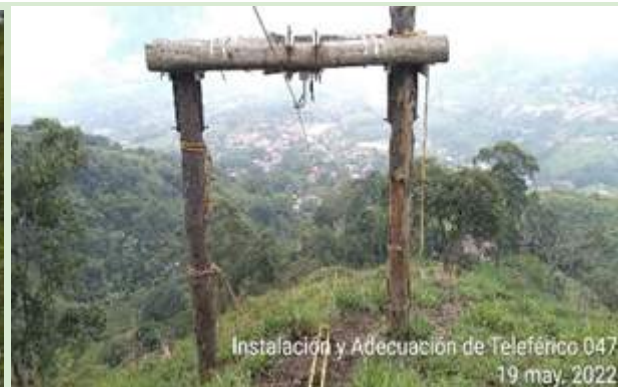
H: Elementos utilizados para darle altura a los cables
