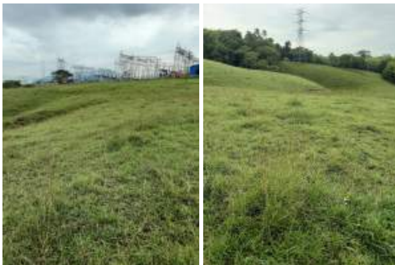
Fotografía 41. Sitio de torre TVA002A-V* y Sitio de torre TVA003V*
