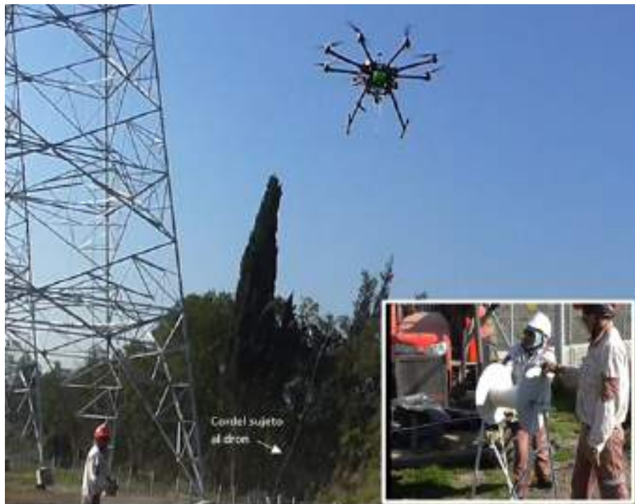
Fotografía 108. Tendido mediante el uso de dron Fuente: GEB (2021).
