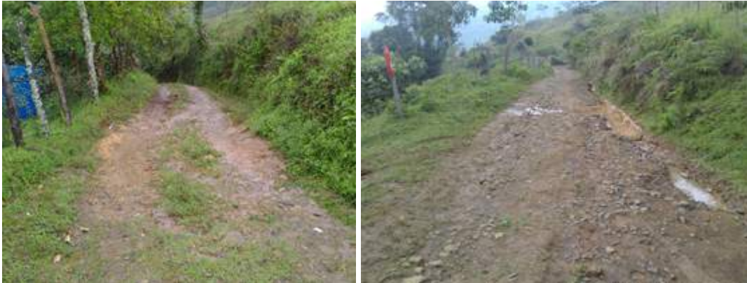
Fotografía 34. Vía veredal Floresta - novillera y Vía veredal Novillera - Castillo
