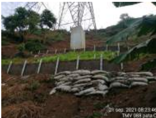
Fotografía 5. Trinchos construidos para el control de la estabilidad del sitio de torre Fuente: GEB. (2022).
