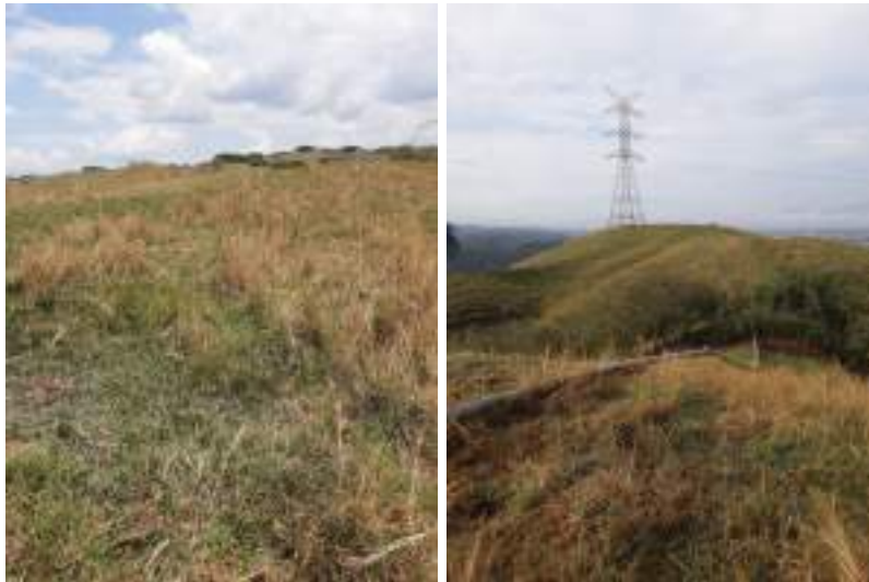
Fotografía 51. Sitio de torre TVA025V y Sitio de torre TVA027
