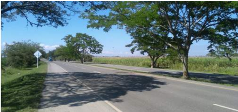
Fotografía 8. Troncal de occidente Tramo Cauca -Palmira
