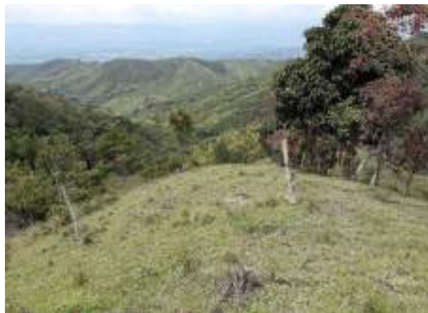
Fotografía 100. Vista panorámica del sector torre TVA286 Fuente: GEB (2018).
