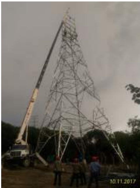
Fotografía 3. Montaje de torre con grúa
