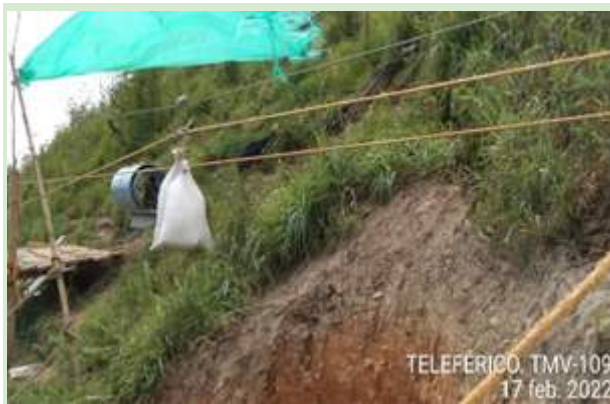
Cables y manilas: Elementos utilizados para llevar los materiales de un punto a otro.
