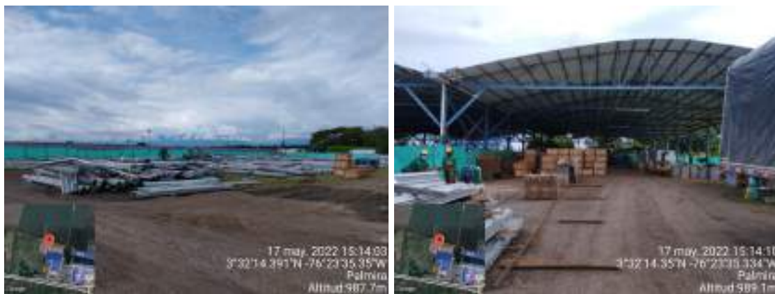
Fotografía 112. Estado Patio de Almacenamiento “Palmira”
