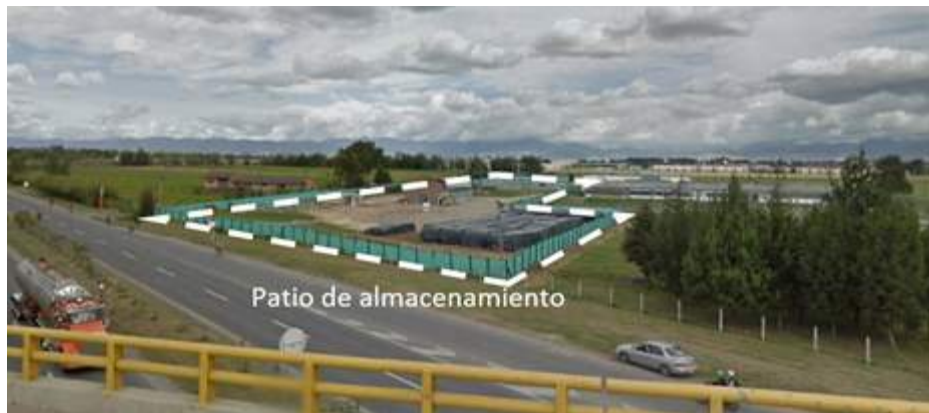
Figura 29. Patio de almacenamiento de materiales Fuente: Google Earth, GEB (2019).
