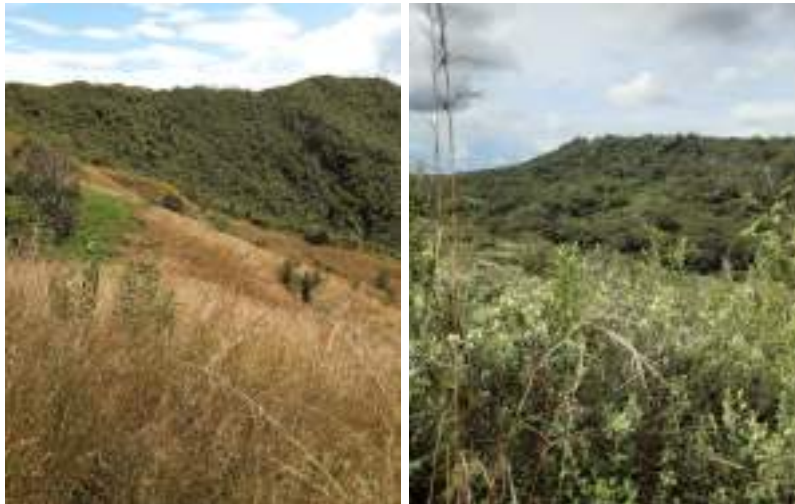
Fotografía 88. Sitio de torre TVA190 y Sitio de torre TVA208
