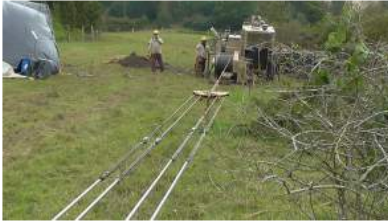
Fotografía 107. Plaza de tendido de malacate Fuente: GEB (2021).
