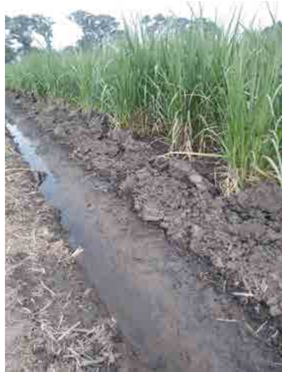
Fotografía 95. Infraestructura de riego y drenaje en la vereda la Regina del municipio de Candelaria.
