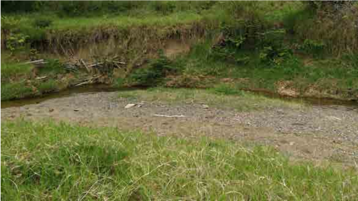
Fotografía 55. Identificación de barra puntual en quebrada de la zona aledaña a la torre TVA082. E 4674830; N 2057918
