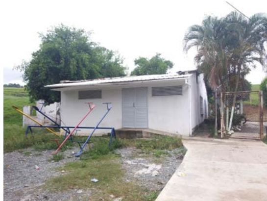
Fotografía 180. Puesto de salud corregimiento Paila Arriba
