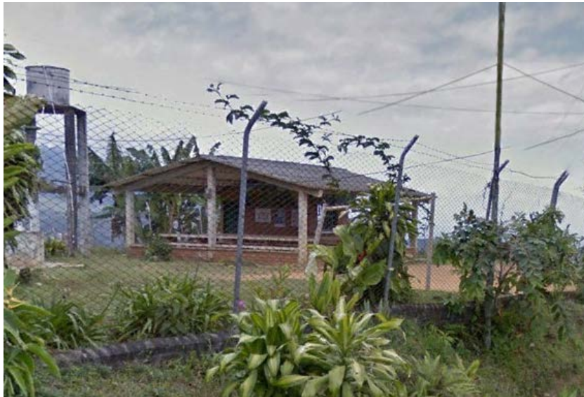
Fotografía 287. Caseta comunal vereda Chafalote
