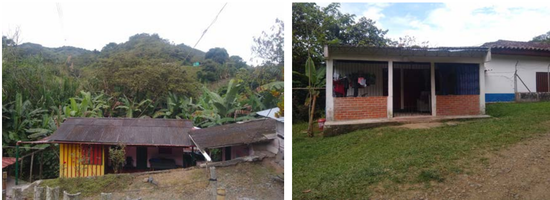
Fotografía 302. Vivienda tipo vereda San Antonio
