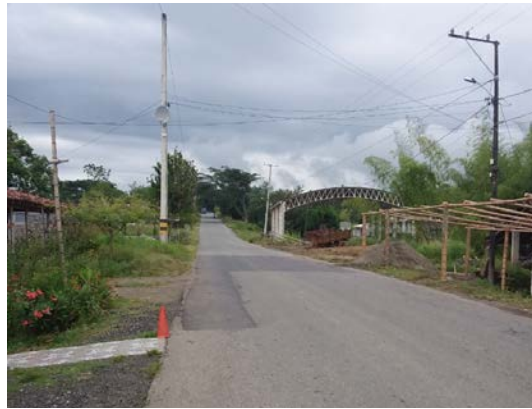
Fotografía 183. Vía La Uribe - Sevilla
