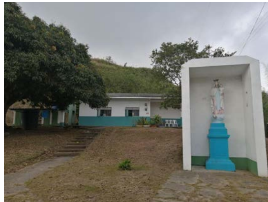
Fotografía 67. Escuela Atanasio Girardot, vereda Buena Vista
