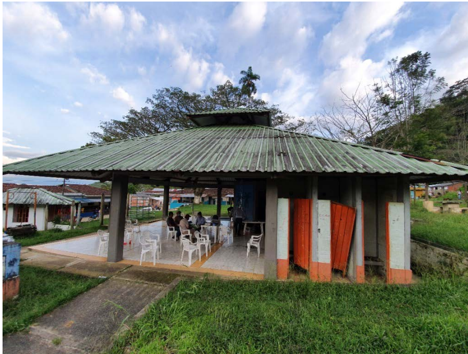
Fotografía 108. Caseta comunal corregimiento Villa Rodas - centro poblado
