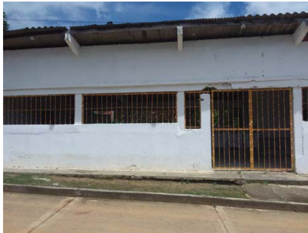
Fotografía 208. Salón comunal corregimiento La Iberia
