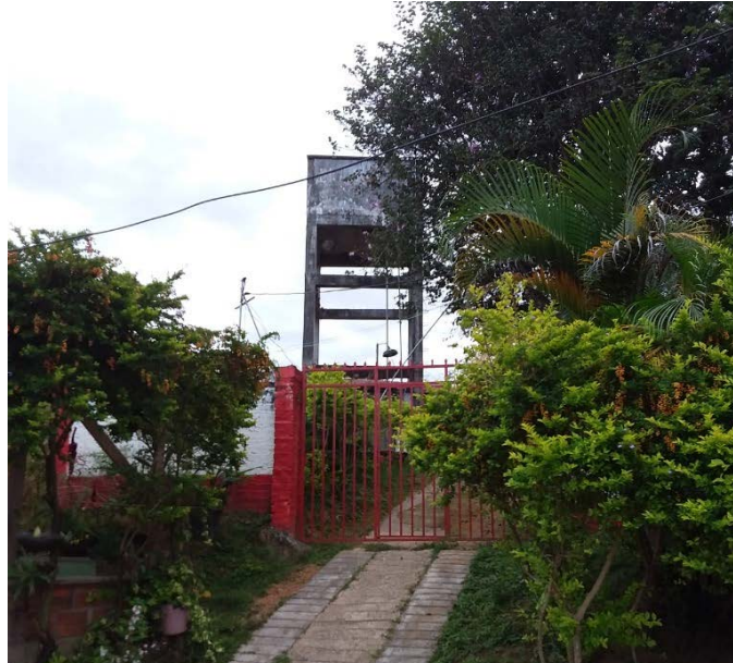
Fotografía 136. Acueducto comunitario corregimiento Taguales
