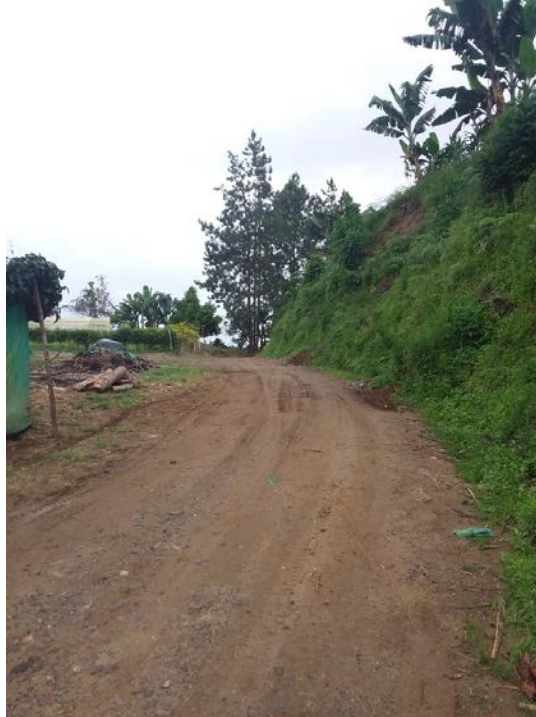
Fotografía 114. Vía Obando - Frías - Cañón del Sande
