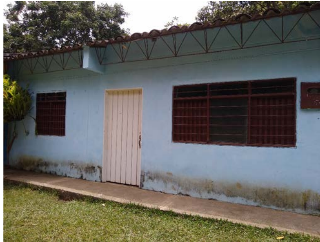
Fotografía 225. Puesto de salud corregimiento Angosturas
