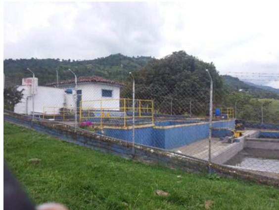
Fotografía 209. Acueducto vereda Colonia Grande
