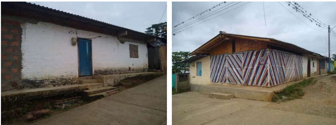
Fotografía 273. Vivienda tipo corregimiento Alto de Guacas
