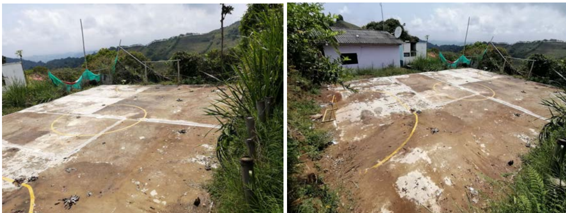
Fotografía 59. Placa polideportiva corregimiento Modín, centro poblado
