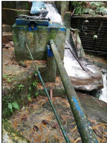
Fotografía 36. Acueducto centro poblado corregimiento Coloradas
