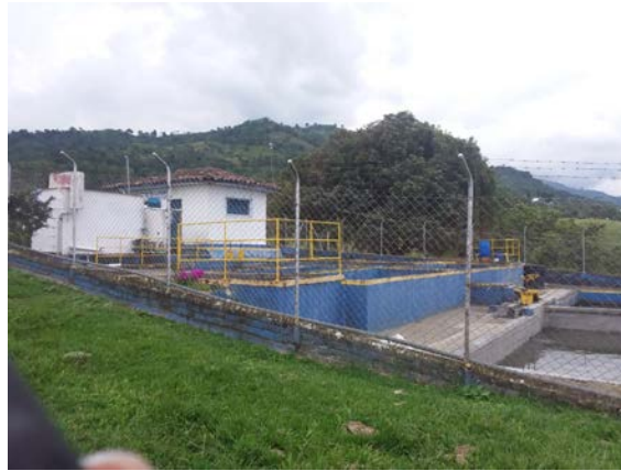
Fotografía 212. Acueducto vereda Colonia Pequeña
