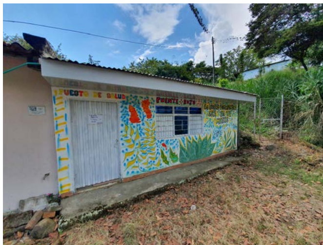
Fotografía 265. Puesto de salud centro poblado corregimiento Puente Rojo
