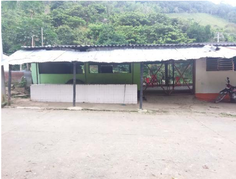
Fotografía 89. Caseta comunal corregimiento San Isidro - centro poblado Tabla 206. Coordenadas caseta comunal corregimiento San Isidro - centro poblado
