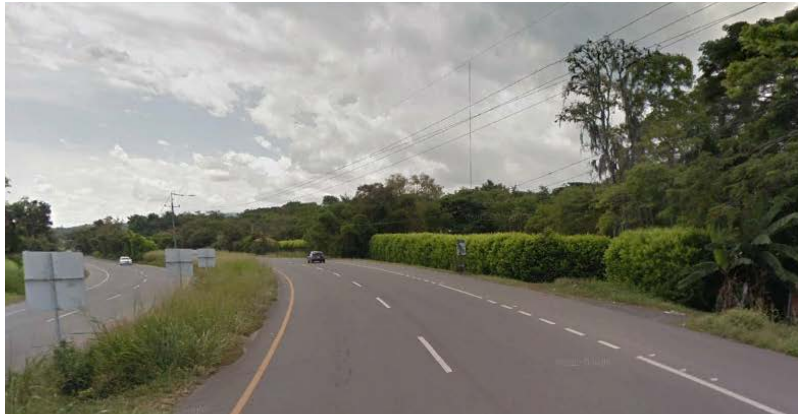
Fotografía 296. Vía Panamericana a la altura de Sonso
