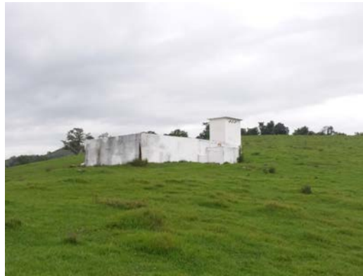
Fotografía 178. Acueducto corregimiento Paila Arriba
