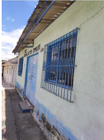
Fotografía 33. Caseta comunal corregimiento Puerto Caldas, sector Las Camelias
