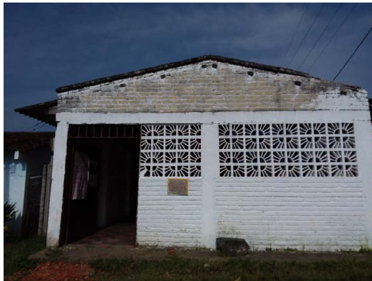
Fotografía 275. Caseta comunal corregimiento Alto de Guacas
