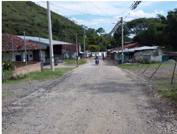
Fotografía 268. Vía Costa Rica - Puente Rojo
