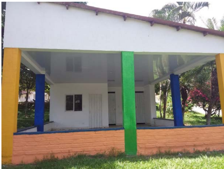
Fotografía 165. Caseta comunal corregimiento Vallejuelo, sector Alto
