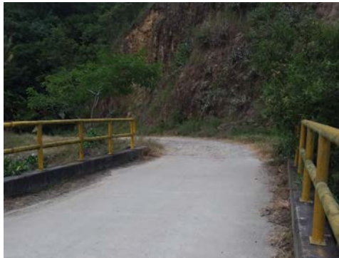
Fotografía 223. Vía Tuluá - Puente de Zinc
