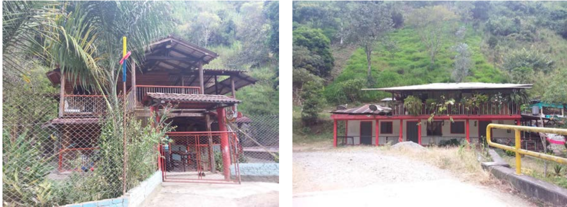
Fotografía 222. Vivienda tipo vereda Puente de Zinc
