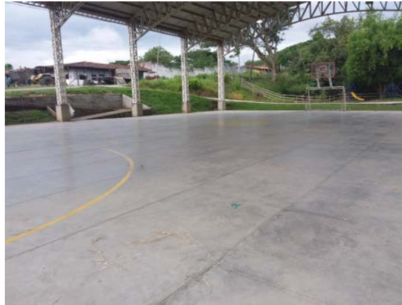
Fotografía 181. Placa polideportiva corregimiento Paila Arriba
