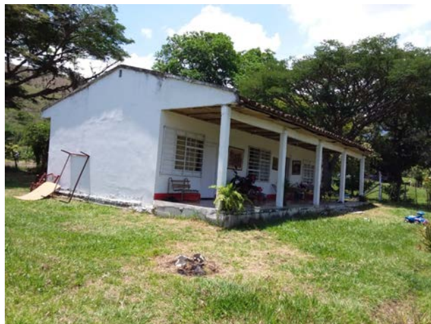
Fotografía 288. Escuela vereda El Tablazo
