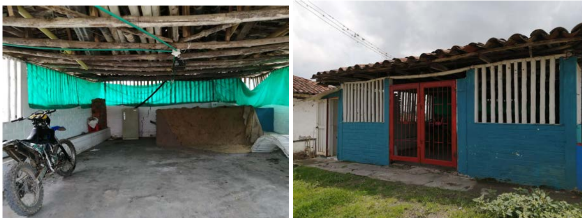
Fotografía 64. Caseta comunal Modín - centro poblado
