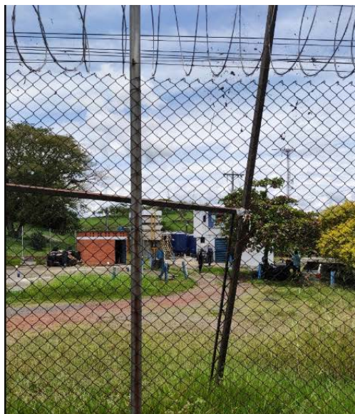
Fotografía 26. Infraestructura del acueducto Aguas y Aguas de Pereira
