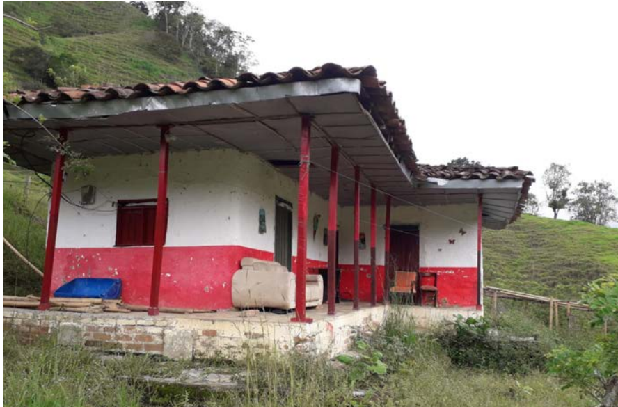
Fotografía 117. Vivienda tipo vereda Sierra Mocha
