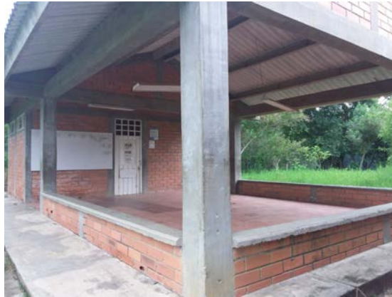
Fotografía 184. Caseta comunal corregimiento Paila Arriba
