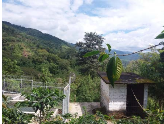
Fotografía 204. Acueducto corregimiento La Iberia
