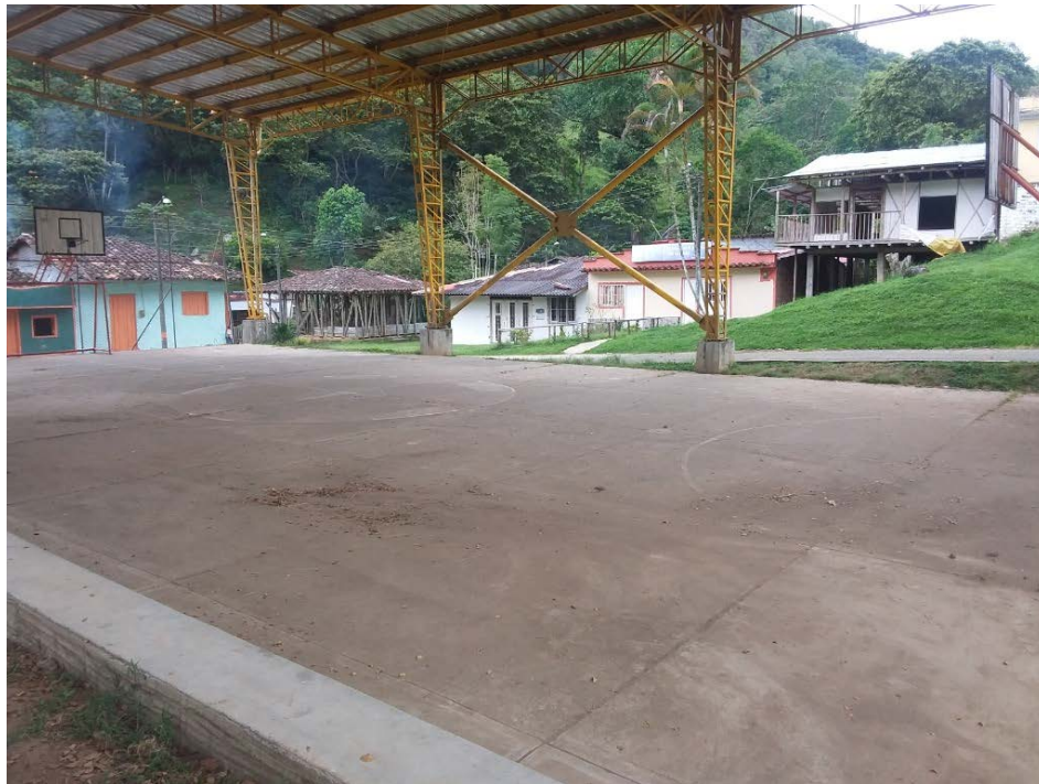
Fotografía 82. Placa deportiva corregimiento San Isidro - centro poblado
