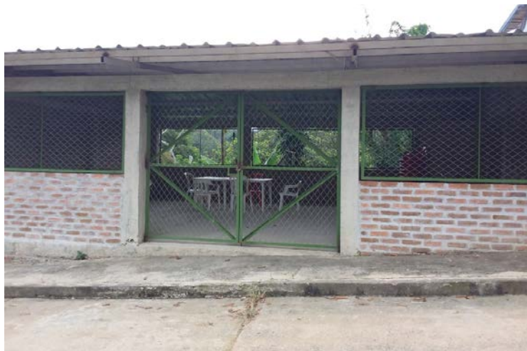
Fotografía 142. Caseta comunal corregimiento Taguales
