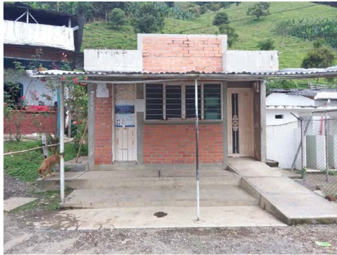
Fotografía 191. Puesto de salud corregimiento Pardo
