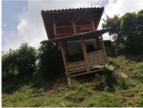
Fotografía 62. Vivienda tipo vereda Oriente
