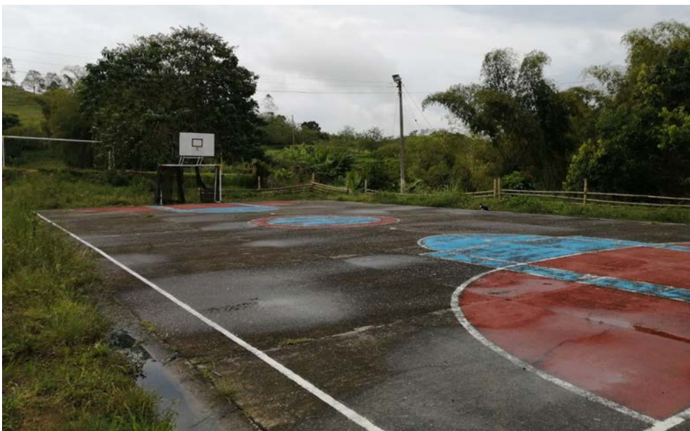
Fotografía 42. Placa polideportiva corregimiento Coloradas, centro poblado
