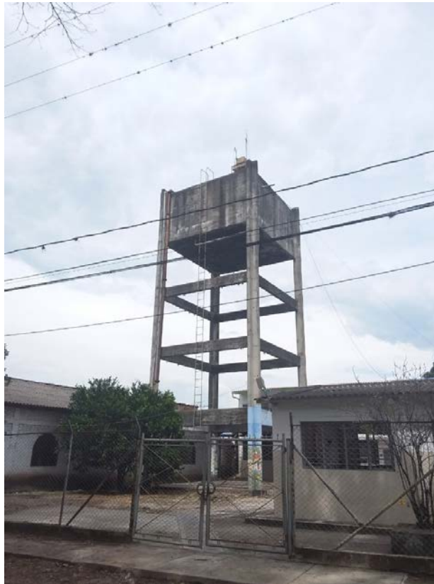
Fotografía 408. Acueducto corregimiento El Tiple
