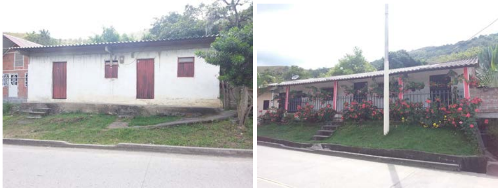
Fotografía 326. Vivienda tipo vereda Bello Horizonte
