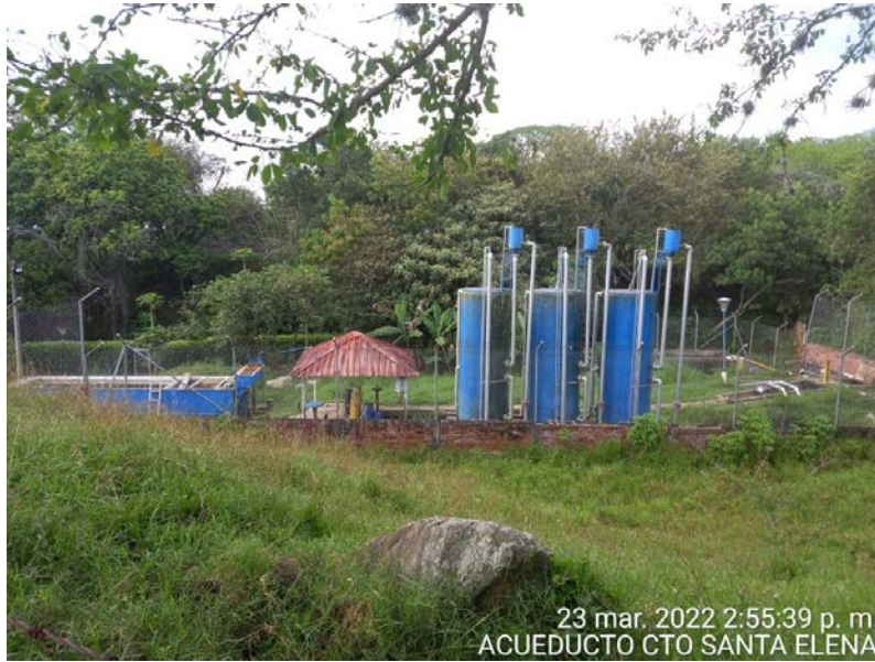
Fotografía 341. Acueducto corregimiento Santa Elena
