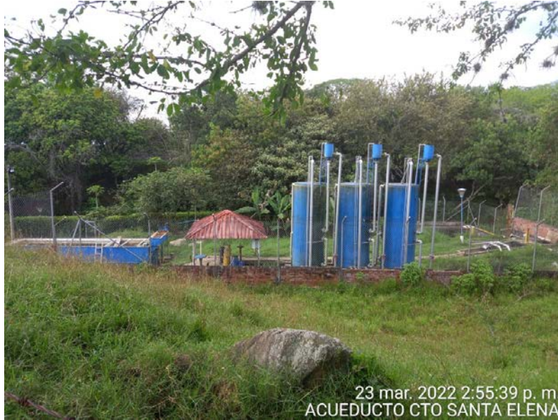
Fotografía 356. Acueducto corregimiento Santa Elena
