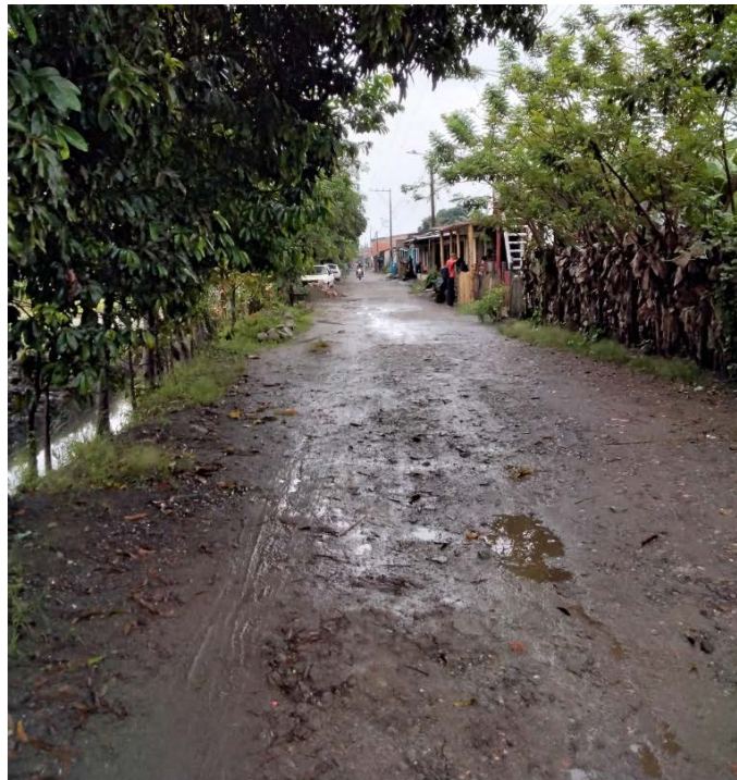
Fotografía 491. Vía La Pampa
