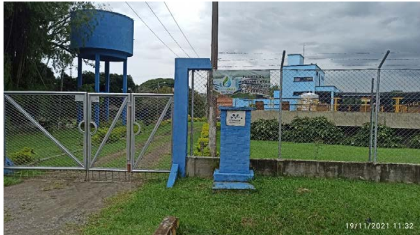
Fotografía 334. Acueducto vereda El Florido
