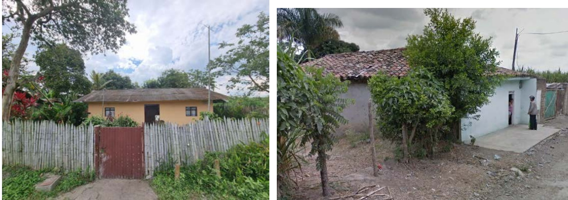
Fotografía 377. Vivienda tipo corregimiento Bolo Hartonal
