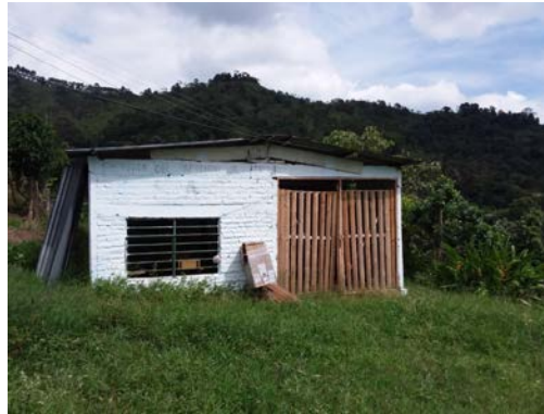
Fotografía 308. Caseta comunal vereda Barranco Alto
