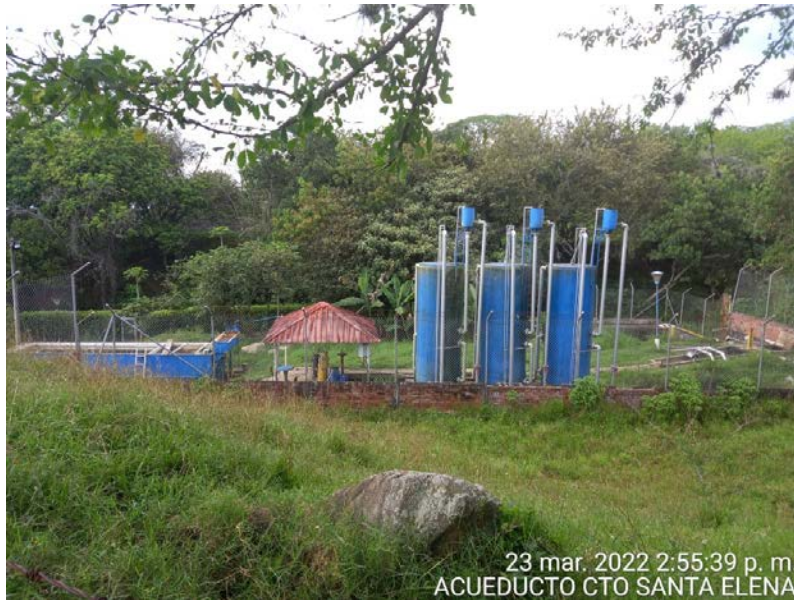
Fotografía 352. Acueducto corregimiento Santa Elena
