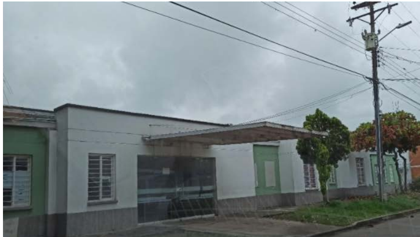
Fotografía 368. Hospital San Rafael, corregimiento El Placer
