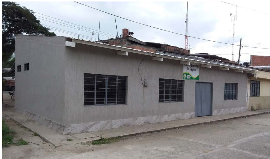
Fotografía 430. Salón comunal centro poblado de La Regina
