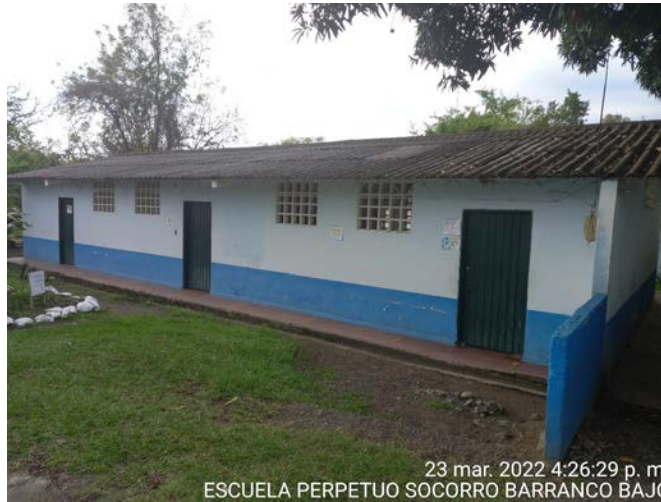
Fotografía 310. Escuela Perpetuo Socorro, vereda Barranco Bajo
