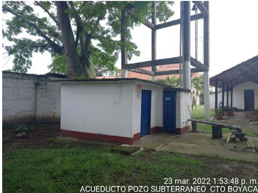
Fotografía 462. Acueducto corregimiento Boyacá
