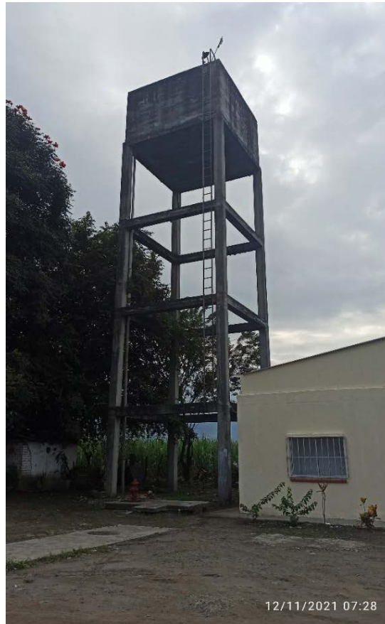
Fotografía 475. Acueducto corregimiento Guayabal
