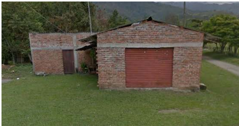
Fotografía 333. Caseta comunal, Loma Gorda Tabla 636. Coordenadas Caseta comunal, Loma Gorda
