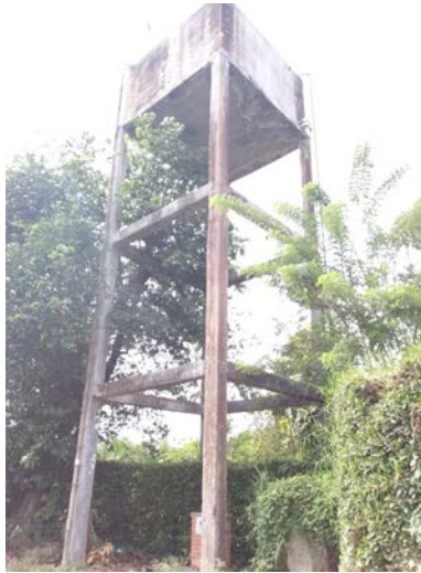
Fotografía 439. Acueducto corregimiento Madre Vieja
