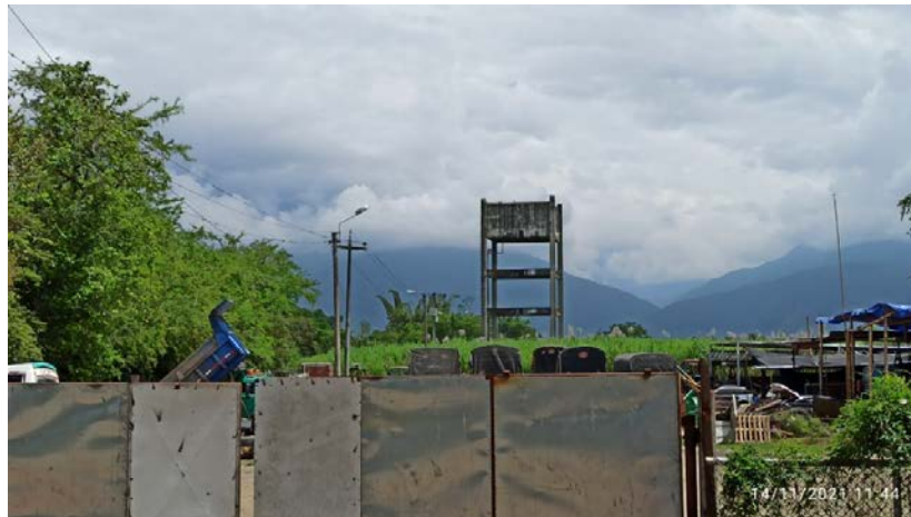
Fotografía 493. Acueducto corregimiento Amaime
