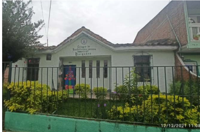
Fotografía 363. Colegio de bachillerato técnico comercial Hargadón, corregimiento El Placer
