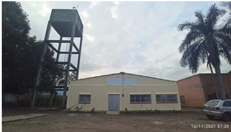
Fotografía 477. Puesto de salud corregimiento Guayabal
