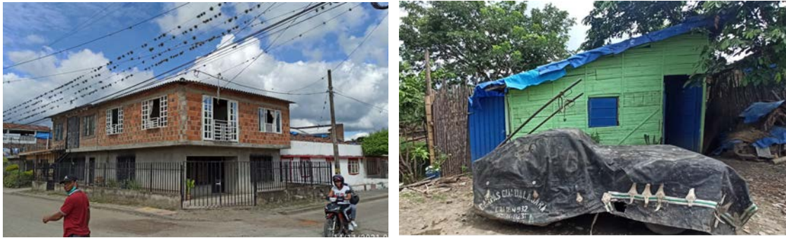
Fotografía 499. Vivienda tipo corregimiento Amaime
