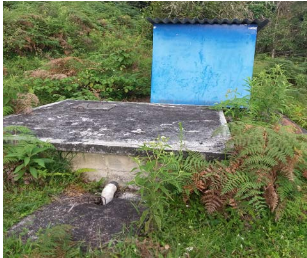
Fotografía 321. Acueducto vereda La Selva
