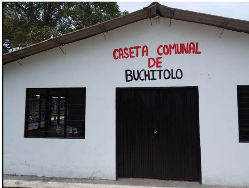
Fotografía 388. Caseta comunal corregimiento Buchitolo
