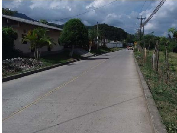
Fotografía 327. Vía Ginebra - Costa Rica (Bello Horizonte)
