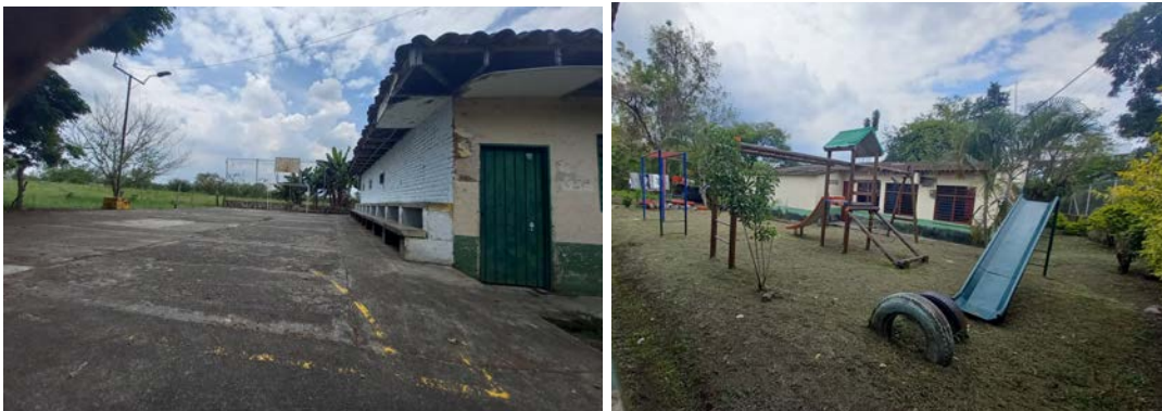
Fotografía 311. Placa deportiva y parque infantil ubicados en la antigua escuela, vereda Barranco Bajo
