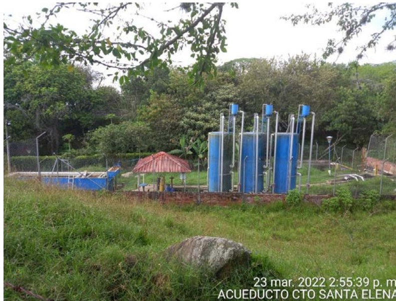
Fotografía 347. Acueducto corregimiento Santa Elena
