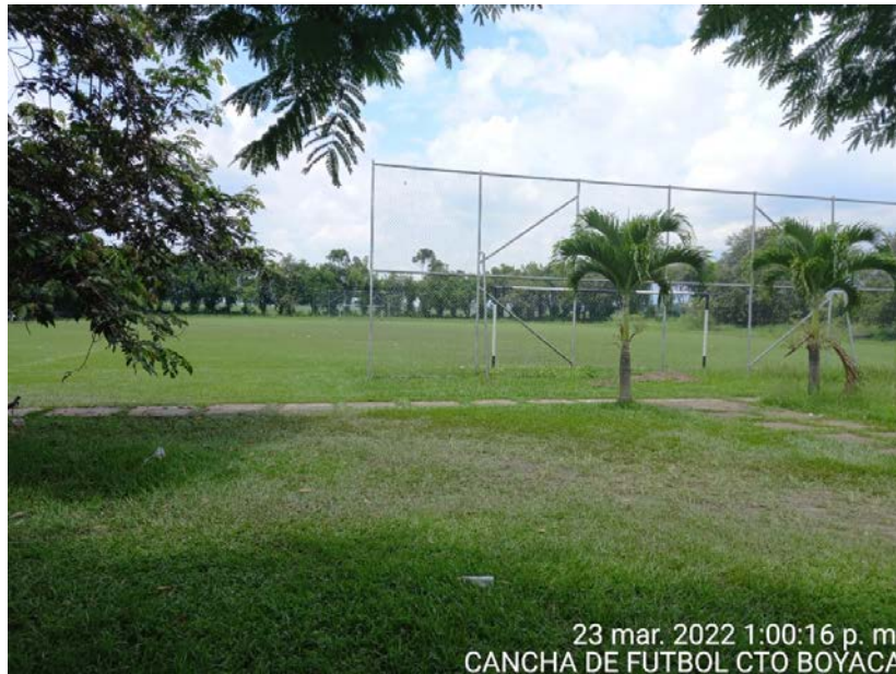
Fotografía 465. Cancha de fútbol corregimiento Boyacá
