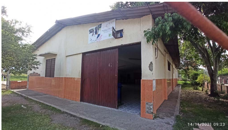
Fotografía 501. Caseta comunal corregimiento Amaime
