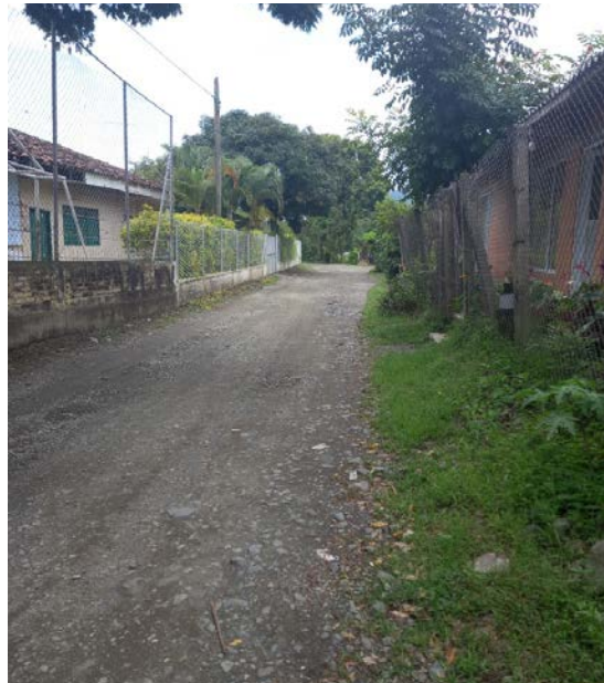
Fotografía 312. Vía Villavanegas - Barranco Alto
