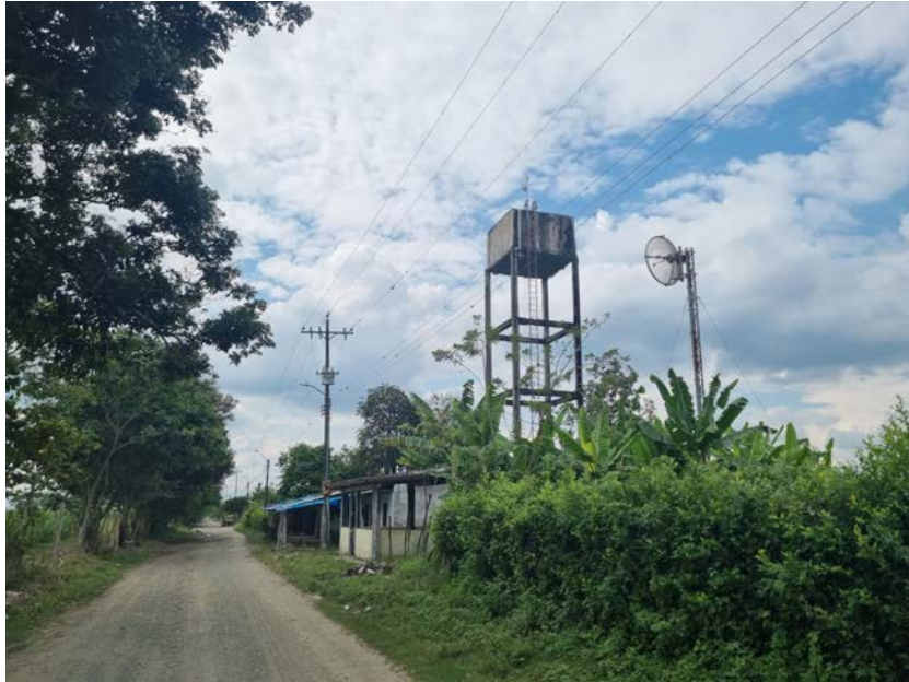
Fotografía 374. Acueducto corregimiento Bolo Hartonal
