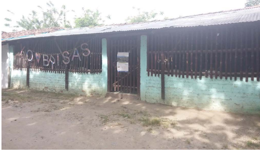
Fotografía 431. Caseta comunal vereda Brisas del Frayle
