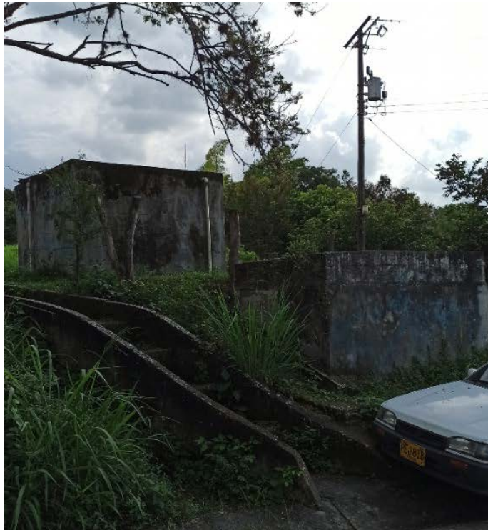
Fotografía 468. Acueducto corregimiento Agua Clara
