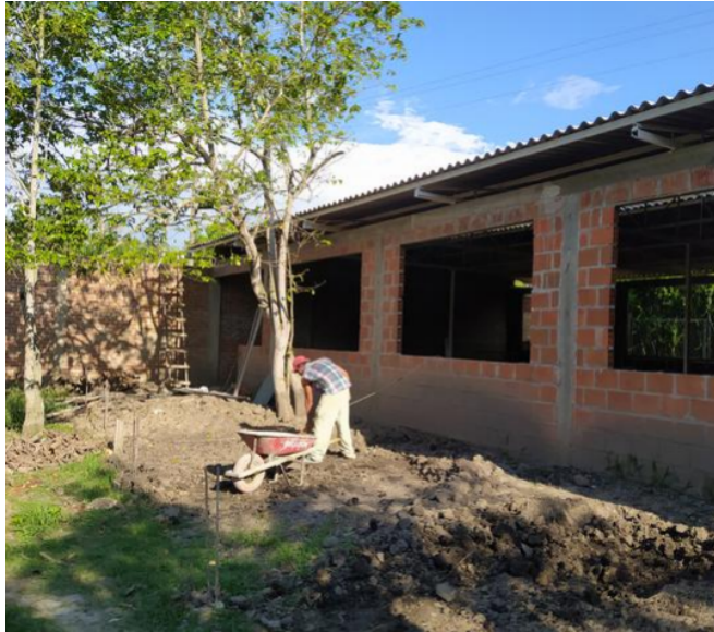
Fotografía 14. Granja porcícola en construcción en predio IG-54. Año 2021
