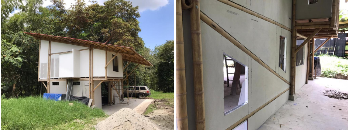
Fotografía 7. Cabaña en construcción en predio El Diamante. Año 2021
