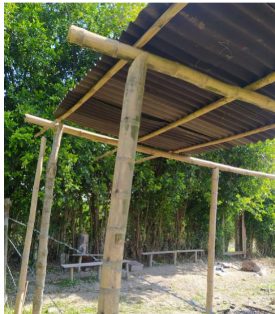
Fotografía 16. Vivienda en construcción en el predio IG-54. Año 2021
