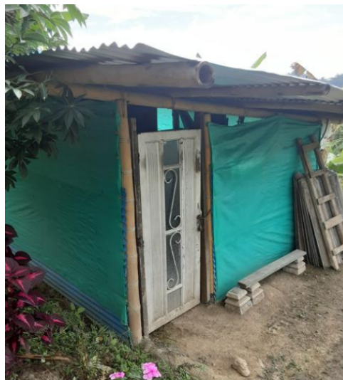
Fotografía 10. Estructura habitacional en construcción en predio El Mirador. Año 2021
