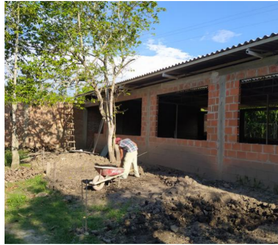
Fotografía 4. Porcícola en construcción IG 54
