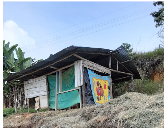
Fotografía 2. Vivienda deshabitada Las Delicias
